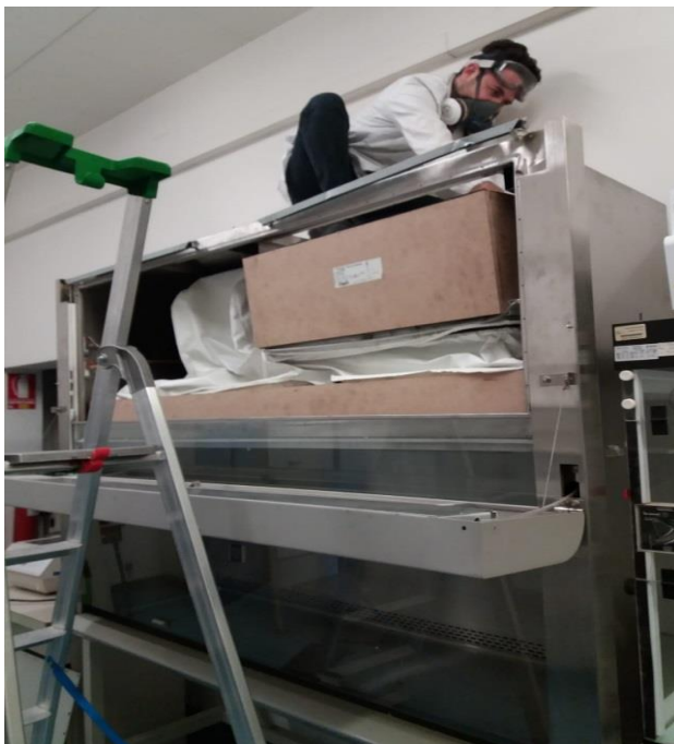
Figura 4.5.5 Il tecnico nell'atto della sostituzione del filtro.
