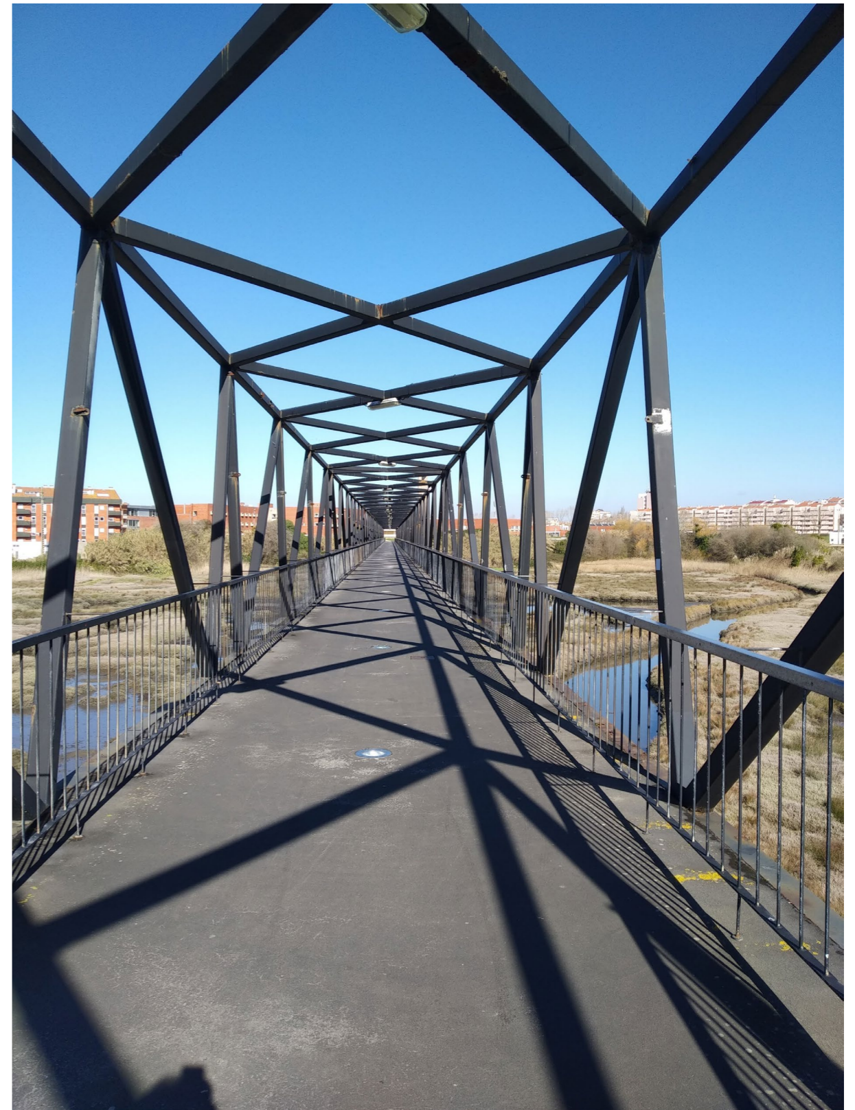
Fig. 54: Ponte ciclo-pedonale, Carrilho da Graça
