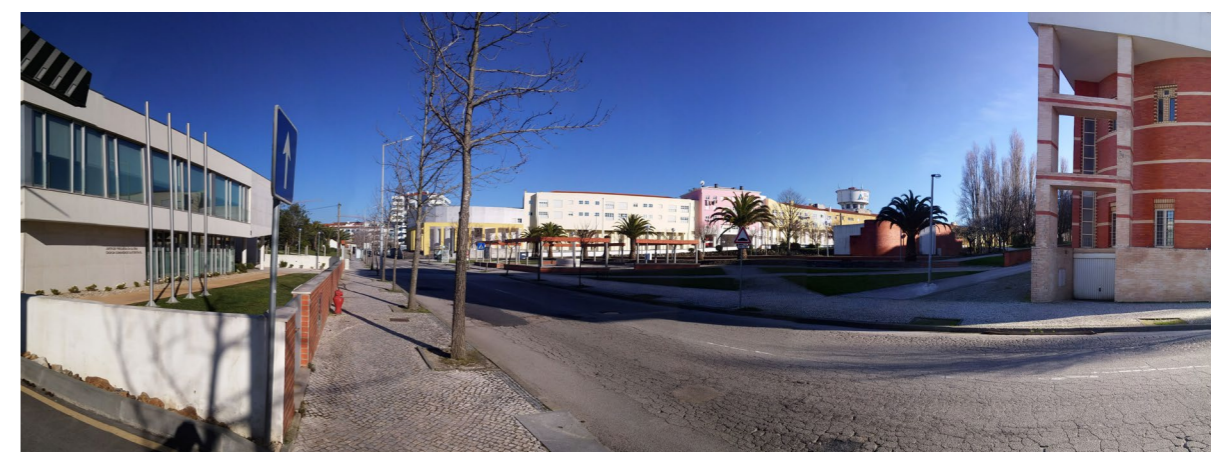
Fig. 66: Vista d'insieme, zona residenziale di Santiago
