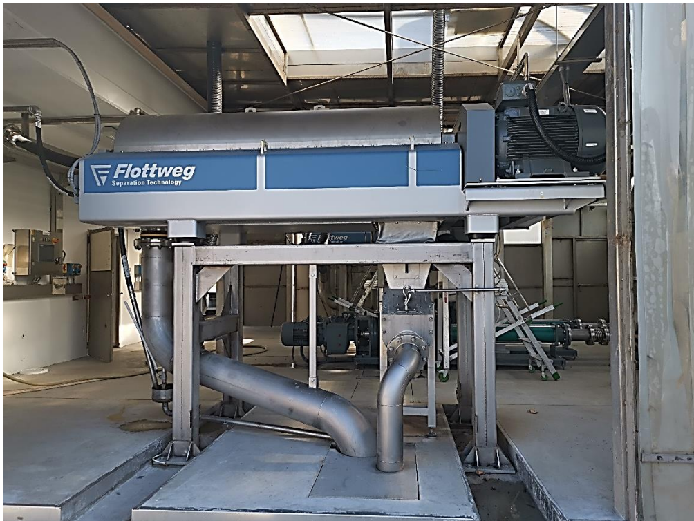
Fig. 37 – Disidratazione attraverso centrifuga
