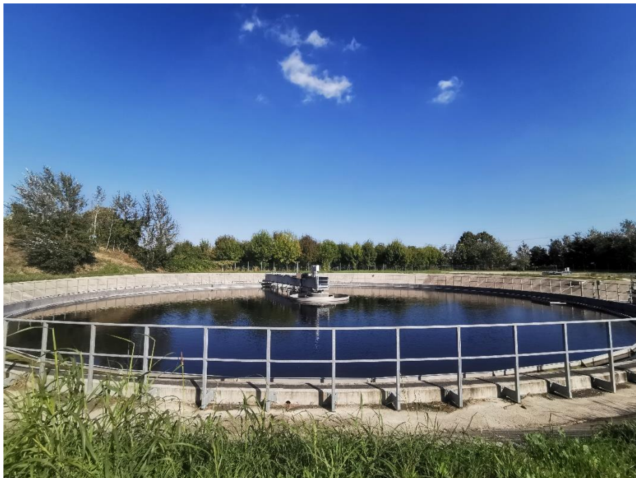
Fig. 35 – Uno dei due sedimentatori secondari di recente costruzione
