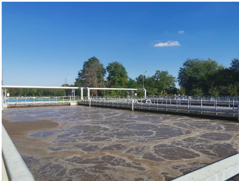
Fig. 33 – Vasca di ossidazione biologica di recente costruzione
