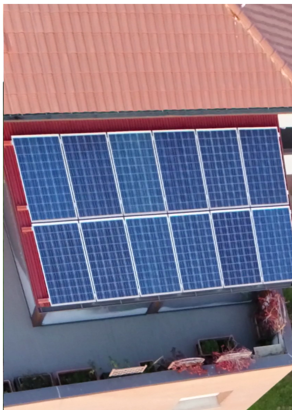
Figura 3.5: Pannelli fotovoltaici utilizzati.
