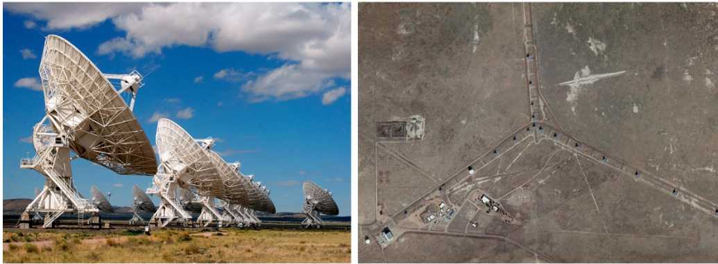
Fig. 3.4: Pannello sinistro: alcune delle radio antenne del JVLA dal diametro di 25m ciascuna. Pannello destro: vista satellitare di parte del complesso del JVLA che si estende per circa 40km, si nota la disposizione ad Y delle antenne nell'array.
