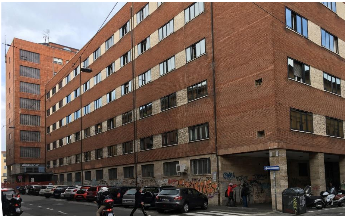
Immagine 3: Viste, aerea e dal piano stradale, del Complesso edilizio studiato all'incrocio tra Via Cirò Menotti e Via Alessandrini - Fonte: fotocoproduzione personale e Google Maps
