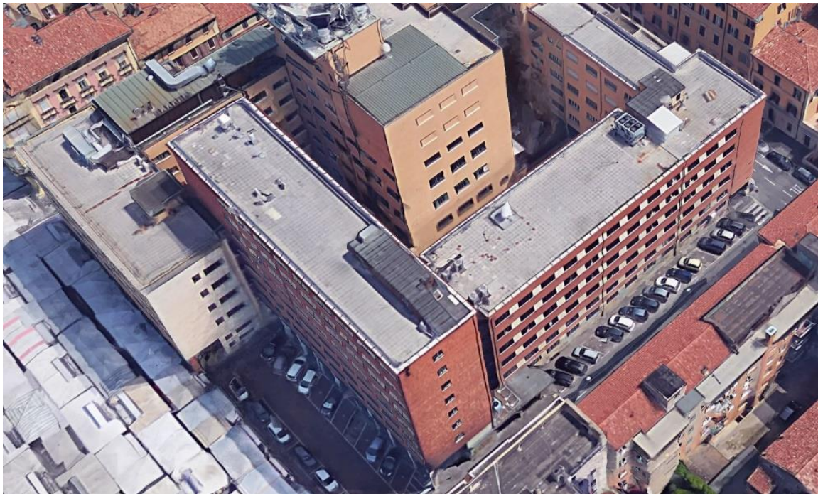
Immagini 2: Viste aeree, delle facciate su Piazza VIII agosto e su Via Ciro Menotti, del Complesso edilizio studiato – Fonte: Google Maps
