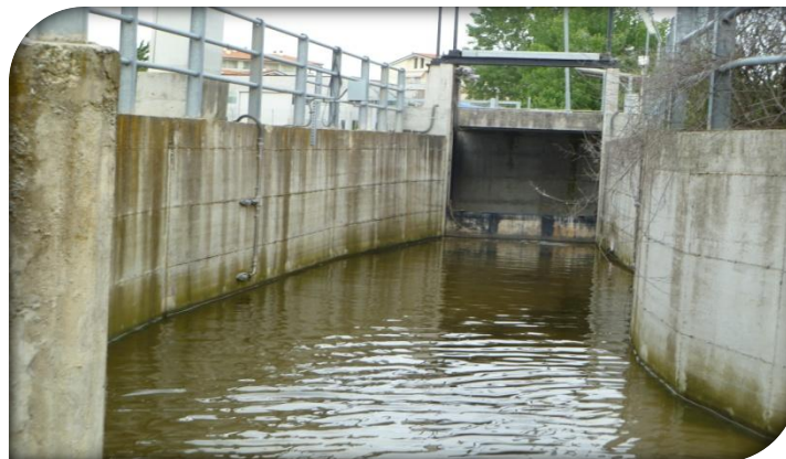
Figura 1. 7: Canale di imbocco
