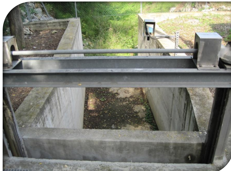
Figura 1. 12: Vista seconda paratoia scolmatore "Rodella"
