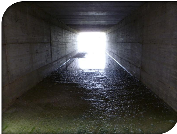
Figura 1.9: Canale di collegamento alla vasca
