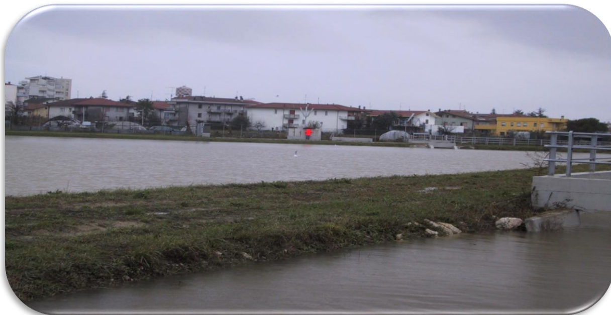
Figura 3. 15: Stato della vasca al termine dell'evento (punto di vista Rodella)
