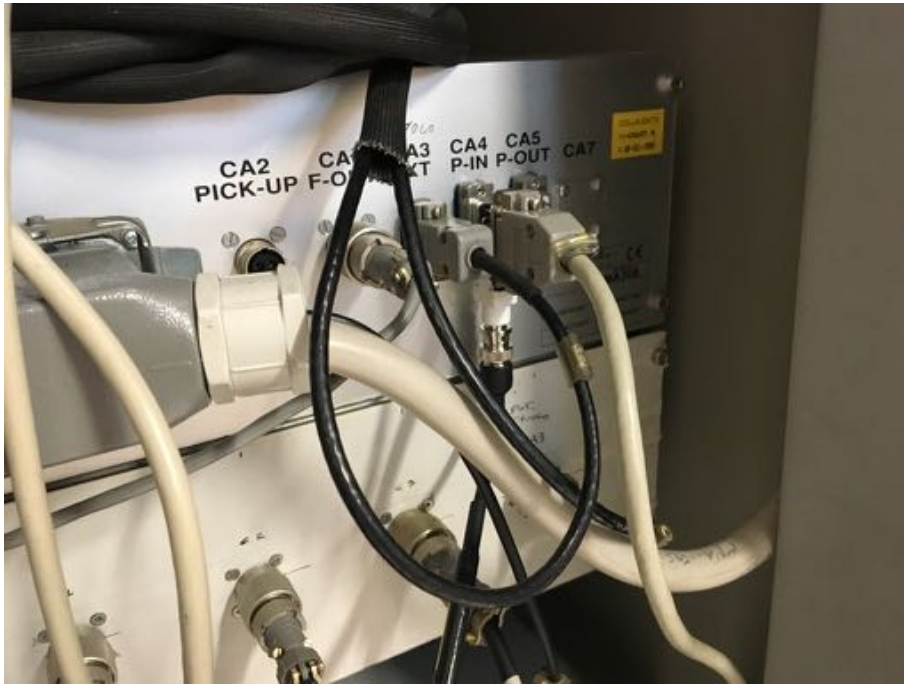
Figura 3.9 – Vista dell'ingresso CA4 con il connettore per il prelievo del segnale
