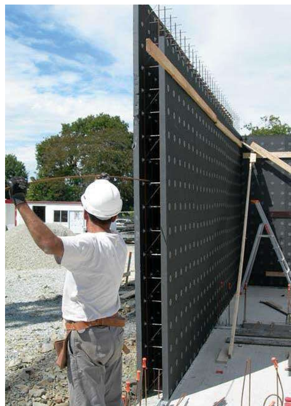
Fig. 5.8 - Posa della muratura PLASTBAU® 3.
