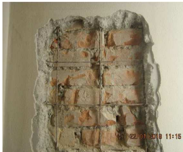
Figura 8: Saggio con rimozione di spesso strato di intonaco per messa in vista della muratura di laterizi della parete SE dietro a rete metallica elettrosaldata (Controls s.r.l.).
