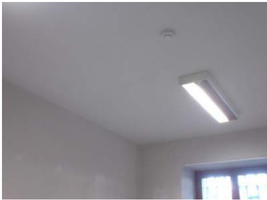
Figura 6.7: Foto del solaio della stanza I19 oggetto di indagine
