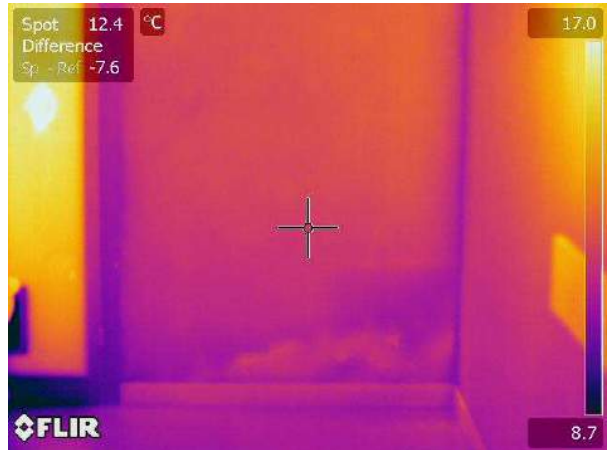
Termogramma originale: IR_18146
