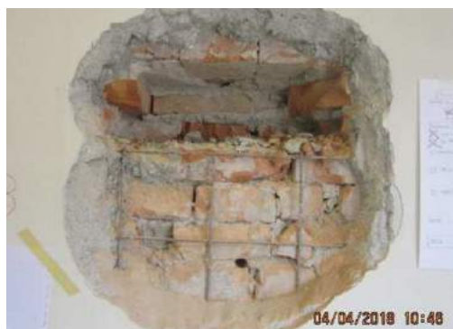
Figura 5.19: Saggio con rimozione di spesso strato di intonaco per messa in vista della muratura di laterizi e prelievo di mattone con manomissione anche della rete metallica elettrosaldata presente (Controls s.r.l., Aprile 2018)
