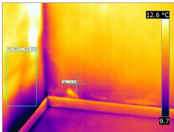
Termogramma modificato: IR_18158
