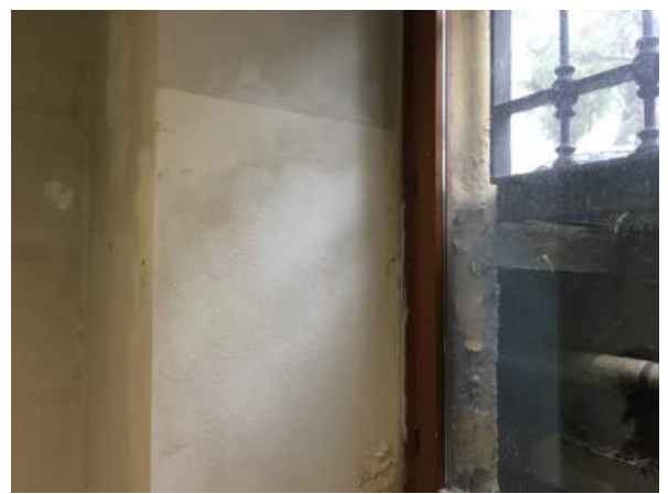
Figura 12: Dalla foto si può notare una soletta esterna spingente, causa forse della fessura.
