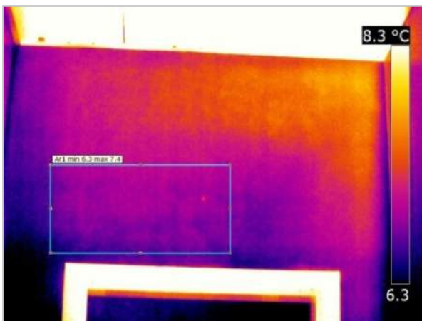
Termogramma modificato: IR_18120
