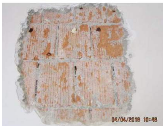
Figura 5.21: Saggio con rimozione dello strato di intonaco eseguito sulla parete SO della stanza R1 per messa in vista della muratura (Controls s.r.l., Aprile 2018).
