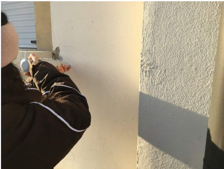
Figura 5.25: Esecuzione della prova sclerometria in sito, alla posizione 1
