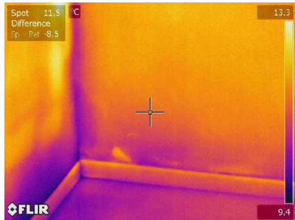
Termogramma originale: IR_18158
