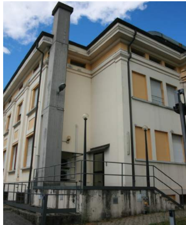
Figura 4: Foto dell'esterno dell'edificio, angolo Est. Si può notare la presenza delle macchine dell'impianto di climatizzazione e canna fumaria in cemento armato.
