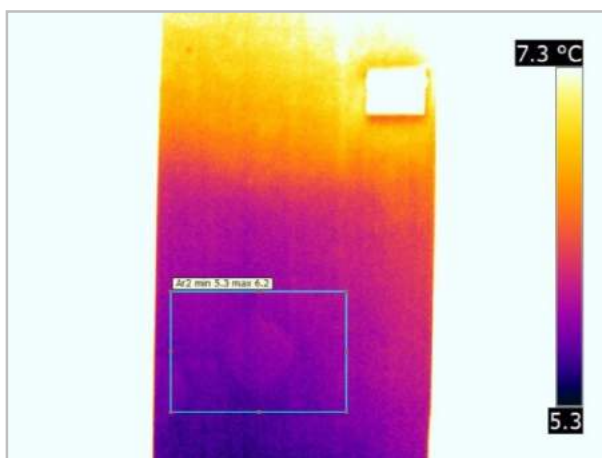
Termogramma modificato: IR_18112
