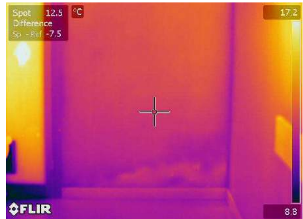
Termogramma originale: IR_18148
