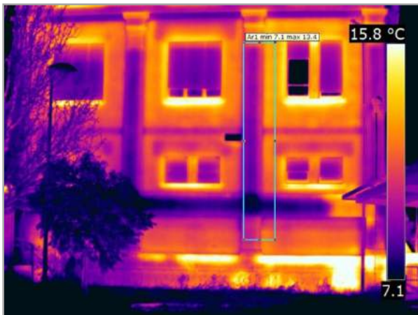
Termogramma modificato: IR_18182
