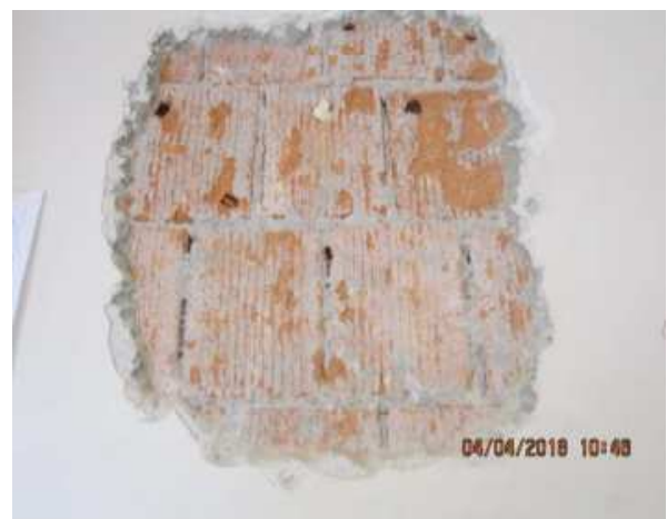
Fig. 5.5: Saggio (Controls) per messa in vista tessitura
