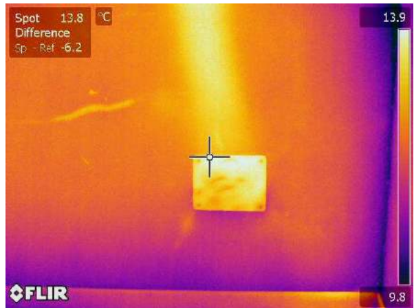
Termogramma originale: IR_18156
