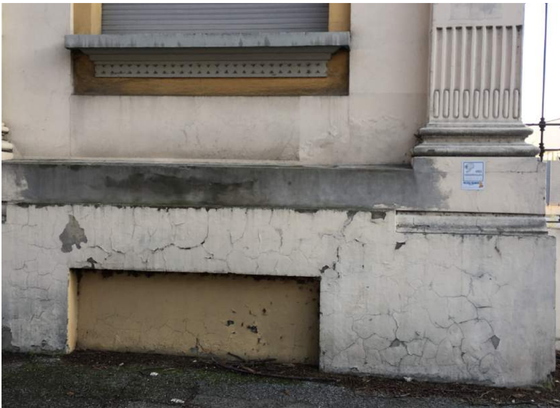
Figura 4.27: Diffusa presenza di cavillature a ragnatela probabilmente imputabili a un intonaco troppo rigido rispetto alla sottostante struttura in muratura accentuata dalla presenza di umidità di risalita dal terreno e limitata traspirabilità della parete.
