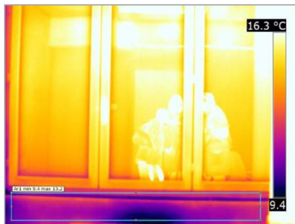
Termogramma modificato: IR_18150
