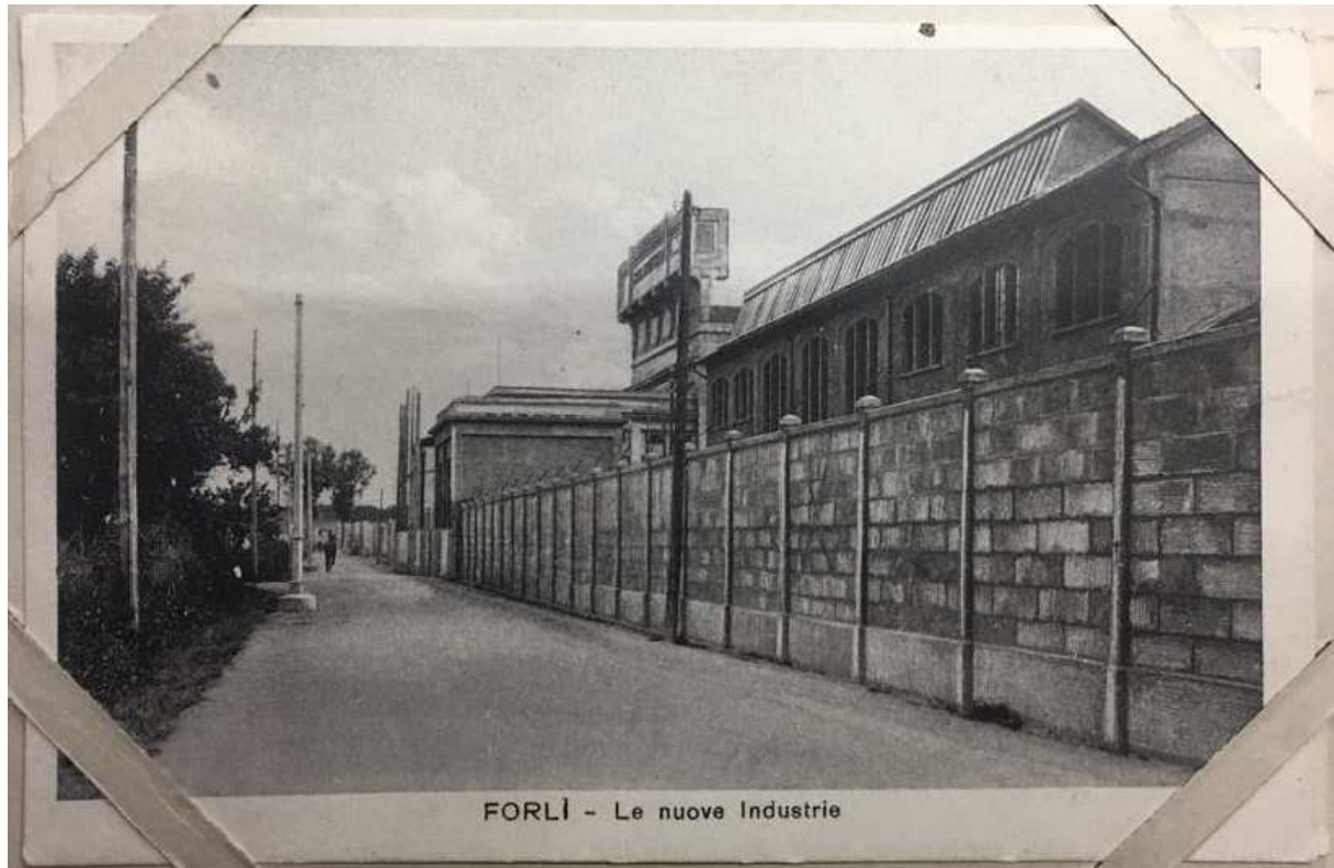
Figura 3.3: 1926-1927, Centrale termoelettrica dello stabilimento Orsi Mangelli (Biblioteca comunale Forlì, Raccolta Piancastelli, Sez. Cartoline Romagnole, Album Forlì 5C / 1031)
