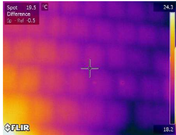
Termogramma originale: IR_18074
