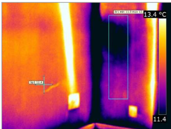
Termogramma modificato: IR_18138
