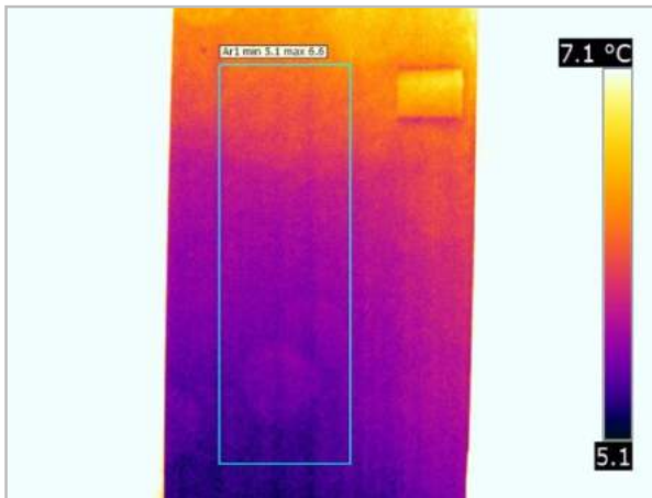
Termogramma modificato: IR_18098
