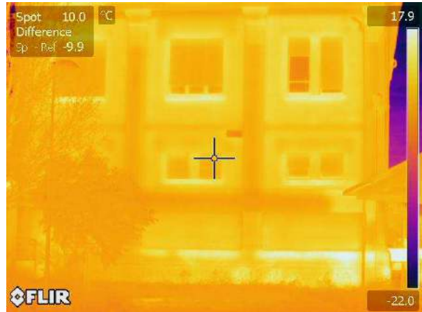
Termogramma originale: IR_18182
