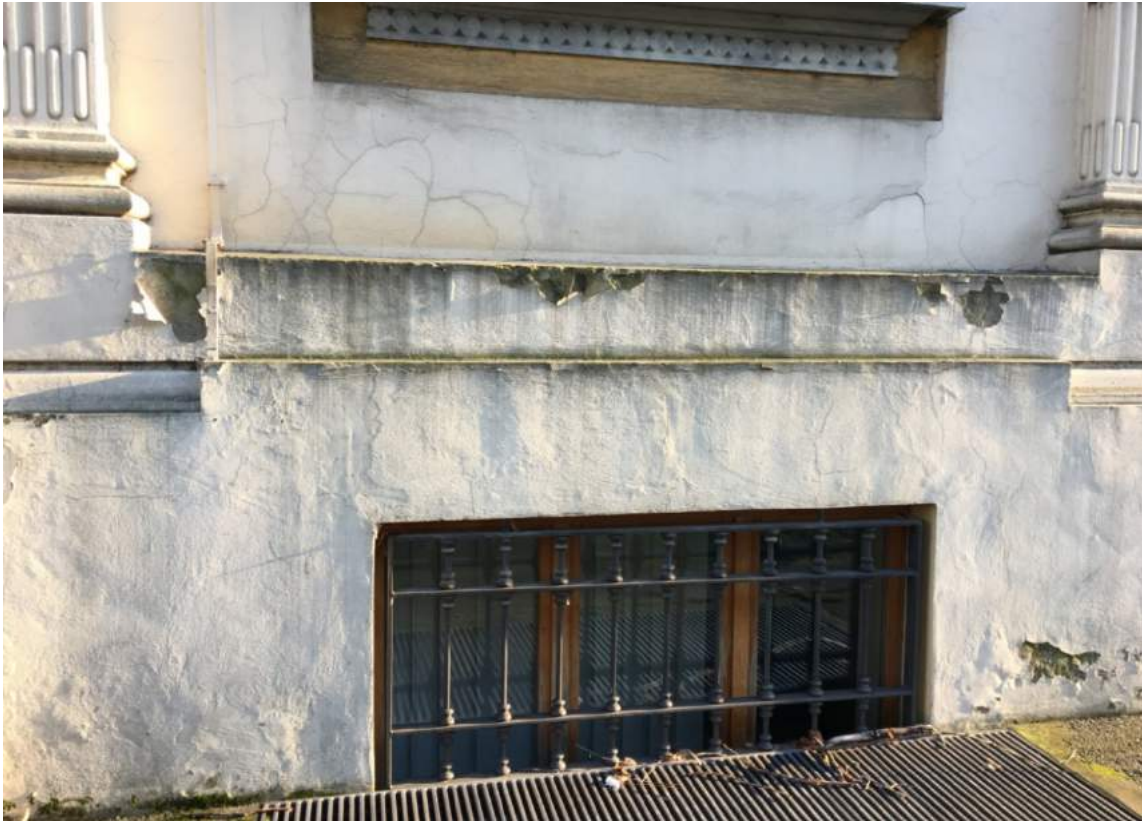
Figura 4.24: Distacco della pellicola di tinteggiatura in vari punti; la luce radente evidenzia i rigonfiamenti
