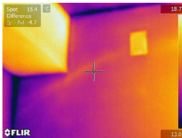
Termogramma originale: IR_18128
