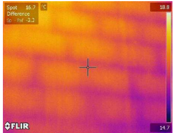
Termogramma originale: IR_18086
