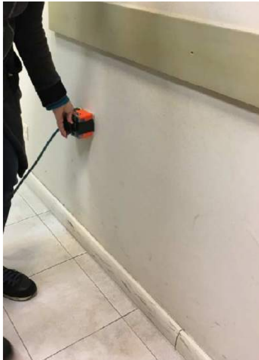
Figura 5.18: Foto scattata durante l'acquisizione di una linea radar orizzontale sulla parete NE della stanza R1, situata al primo piano dell'edificio.
