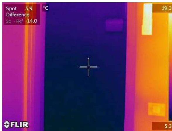
Termogramma originale: IR_18104
