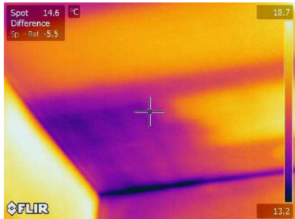
Termogramma originale: IR_18130
