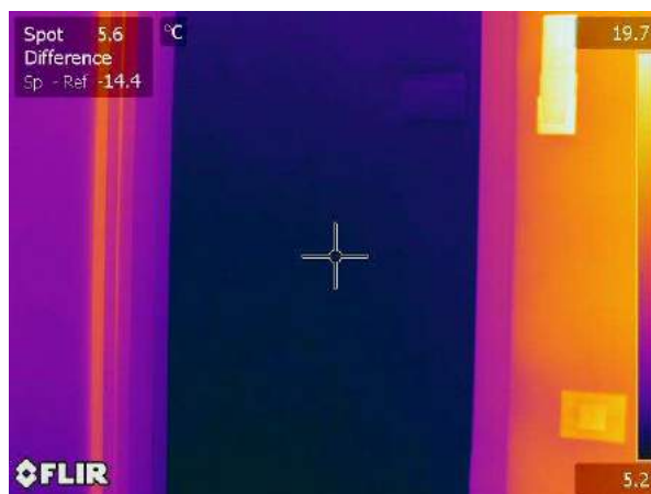
Termogramma originale: IR_18100
