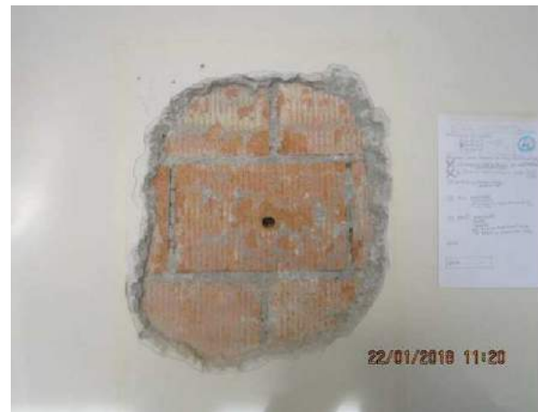
Figura 6: Saggio (Controls) per messa in vista della tessitura muraria
