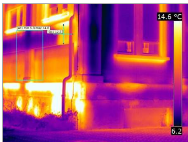
Termogramma modificato: IR_18176
