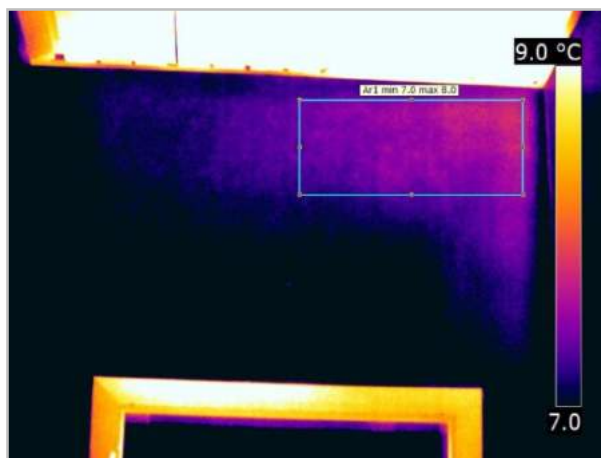
Termogramma modificato: IR_18122
