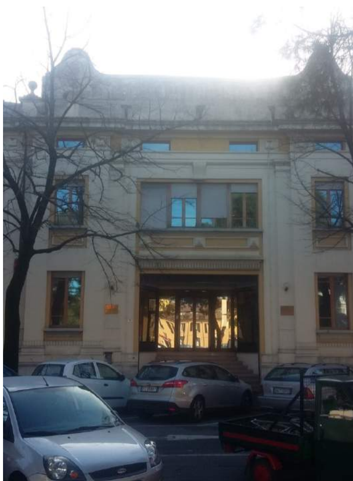
Figura 3.8: Particolare dell'ingresso a ponte dell'edificio, oggi chiuso in seguito ai lavori eseguiti negli anni 1988-1990
