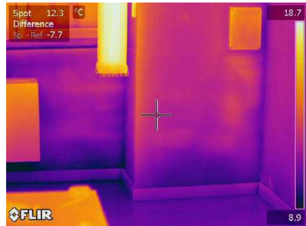
Termogramma originale: IR_18154
