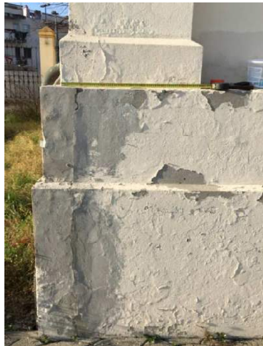
Figura 4.22: La luce solare radente mostra diffusa presenza di distacchi e rigonfiamenti della pellicola di tinteggiatura, accentuati dalla risalita di umidità che stante l'impermeabilità del rivestimento esterno e quindi non avendo possibilità di "asciugare" traspirando rimane imprigionata creando i fenomeni di distacco e risale a quote maggiori lungo la parete.
