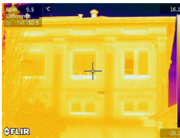
Termogramma originale: IR_18180
