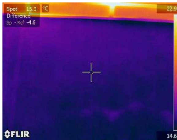
Termogramma originale: IR_18084
