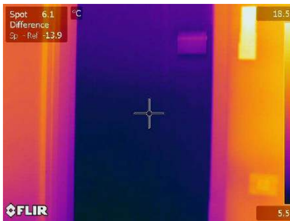
Termogramma originale: IR_18114
