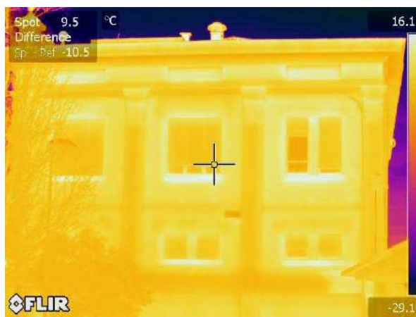
Termogramma originale: IR_18180
