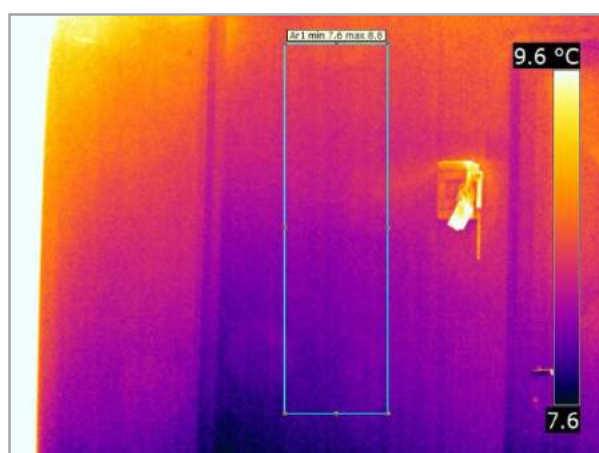
Termogramma modificato: IR_18164
