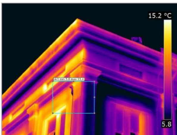
Termogramma modificato: IR_18178
