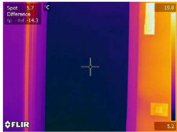
Termogramma originale: IR_18096
