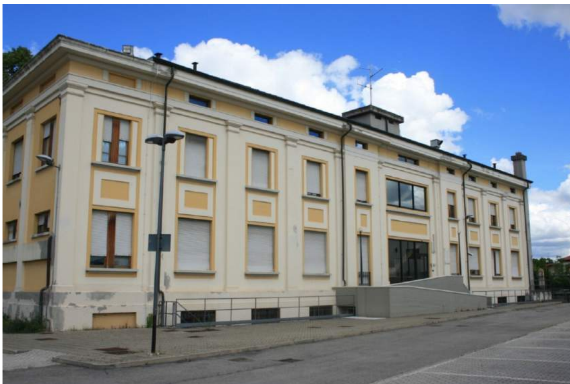
Figura 4.20: vista del fronte SE
