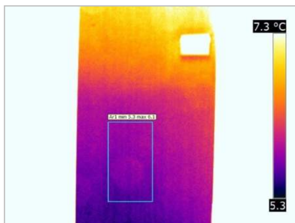
Termogramma modificato: IR_18106
