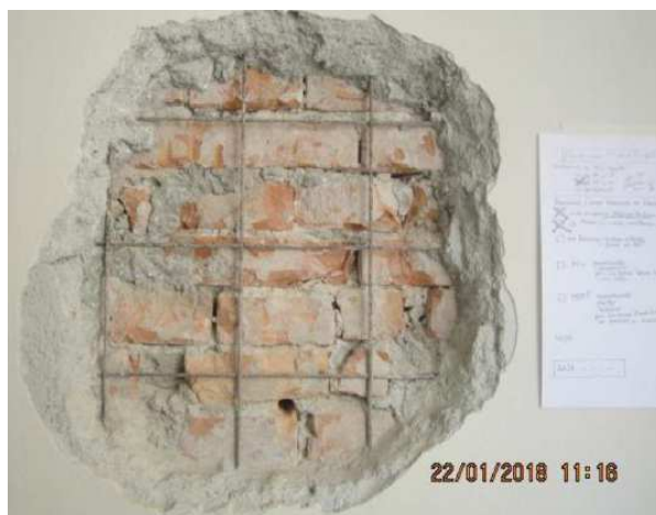
Figura 2: Saggio con rimozione di spesso strato di intonaco per messa in vista della muratura di laterizi della parete NE dietro a rete metallica elettrosaldata (Controls s.r.l., Gennaio 2018)
