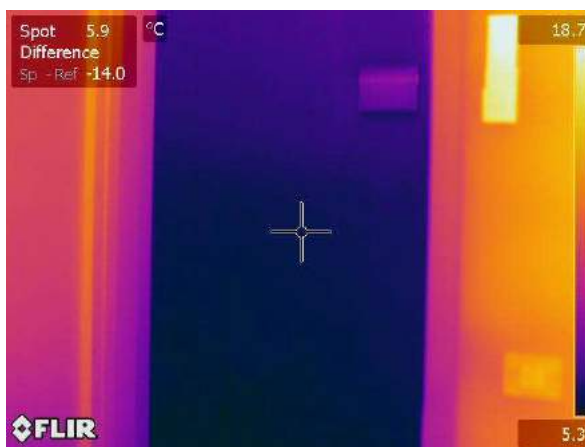
Termogramma originale: IR_18110
