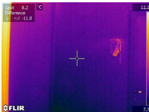
Termogramma originale: IR_18164
