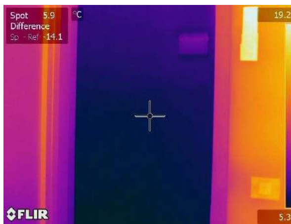
Termogramma originale: IR_18106
