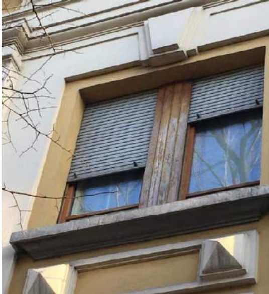
Figura 4.28: ammaloramento dell'infisso ligneo legata alla carenza di manutenzione particolarmente accentuata nel montante centrale; il fatto si spiega in quanto tale porzione è sempre esposta alle intemperie in quanto mai protetta dalle tapparelle che risultanocostituite in questo particolare infisso da due teli separati. Lo stato di degrado non è ancora tale da richiedere la sostituzione dell'infisso, ma ancora facilmente risolvibile mediante “carteggiatura” della superficie e applicazioni a più mani di idonea vernice naturale trasparente.
