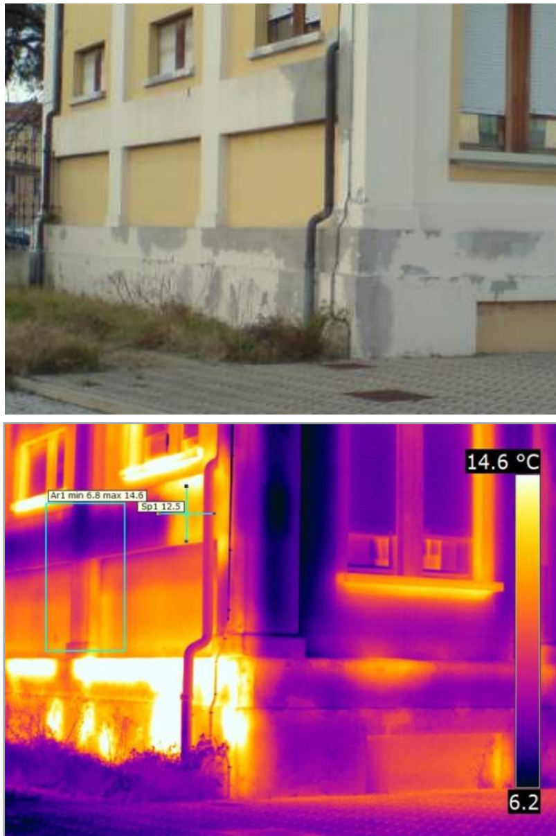
Figura 6.11: Immagine fotografica (in alto) della parete SO e dell'angolo Sud dell'edificio e termogramma IR_80176 (sotto) inquadranti la stessa porzione di area.
