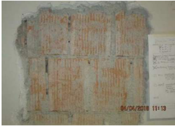
Figura 25: Foto dello scasso effettuato sulla parete NE della stanza P4, prima del prelievo del laterizio (Controls)
