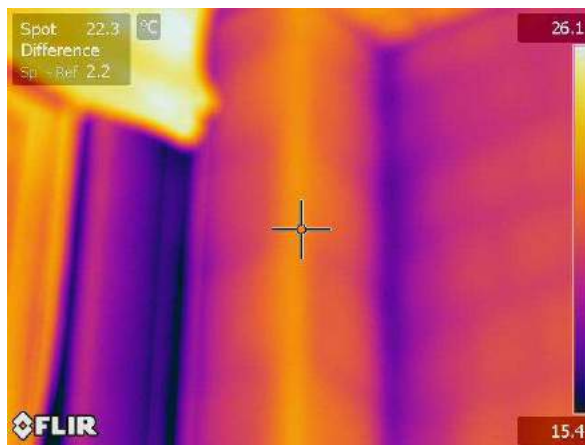
Termogramma originale: IR_18078
