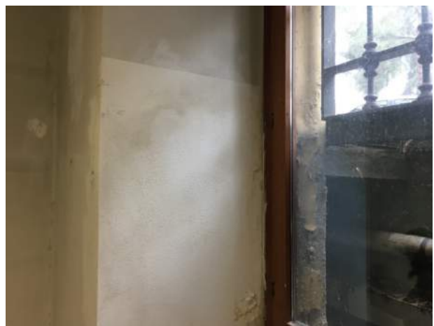
Figura 5.11: Dalla foto si può notare una soletta esterna spingente, causa forse della fessura.
