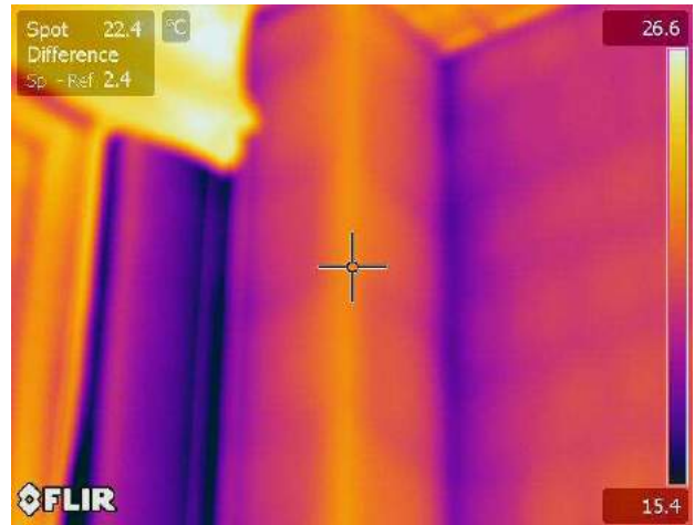
Termogramma originale: IR_18076
