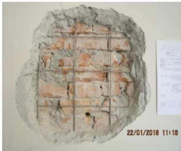
Figura 7: Saggio con rimozione di spesso strato di intonaco per messa in vista della muratura di laterizi della parete NE dietro a rete metallica elettrosaldata (Controls s.r.l.).
