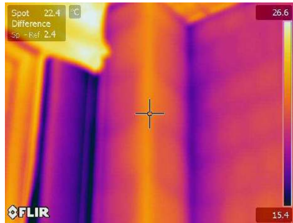
Termogramma originale: IR_18076
