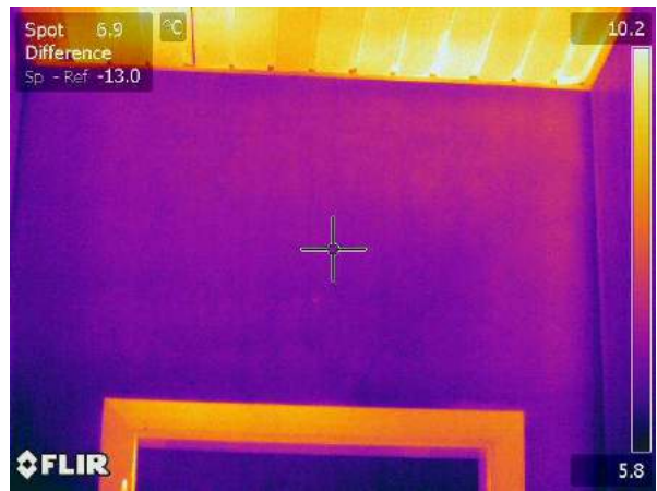
Termogramma originale: IR_18120
