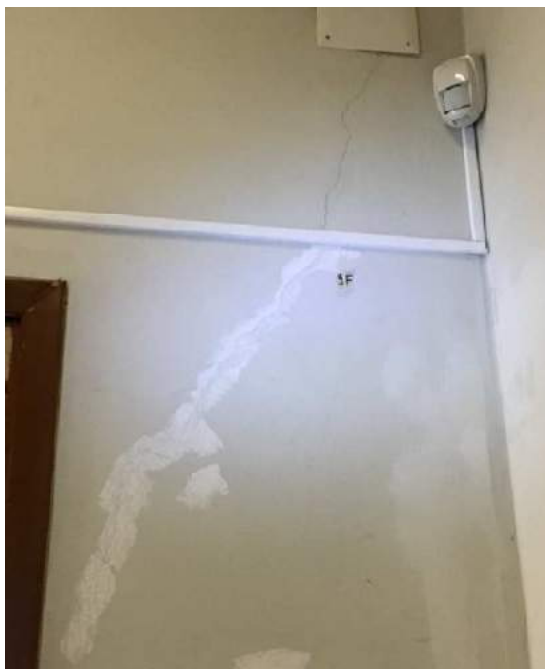
Figura 9: Fessura passante nella parete SE della stanza R27 (parete NE della stanza R25)
