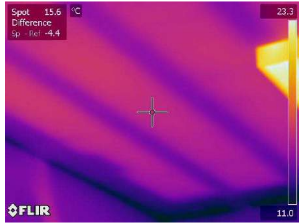
Termogramma originale: IR_18132
