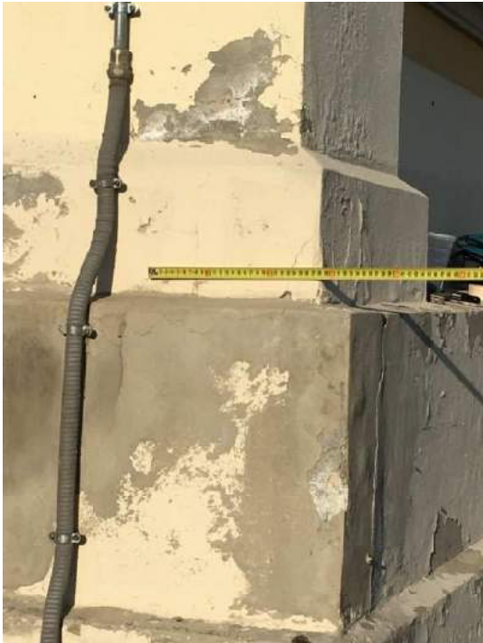
Figura 4.21: Presenza di efflorescenze saline dovute al trasporto ed evaporazione di umidità da risalita con deposito di sali, accentuate dalla presenza di finitura con malta cementizia
