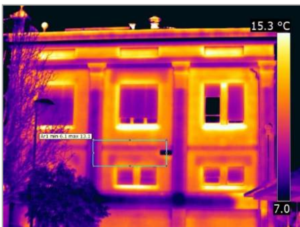
Termogramma modificato: IR_18180
