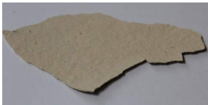
Figura 6.13 Foto della faccia superiore del prelievo (IN.2) del sottile strato di tinteggiatura esterna dell'edificio
