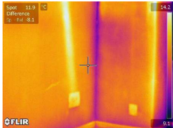
Termogramma originale: IR_18138
