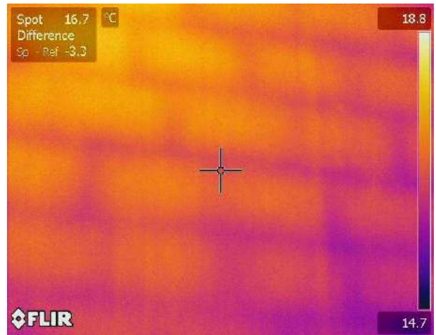
Termogramma originale: IR_18086
