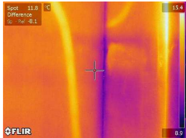
Termogramma originale: IR_18136
