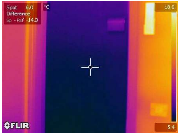
Termogramma originale: IR_18108
