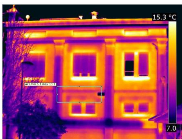
Termogramma modificato: IR_18180
