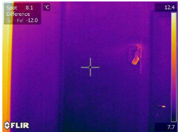
Termogramma originale: IR_18162
