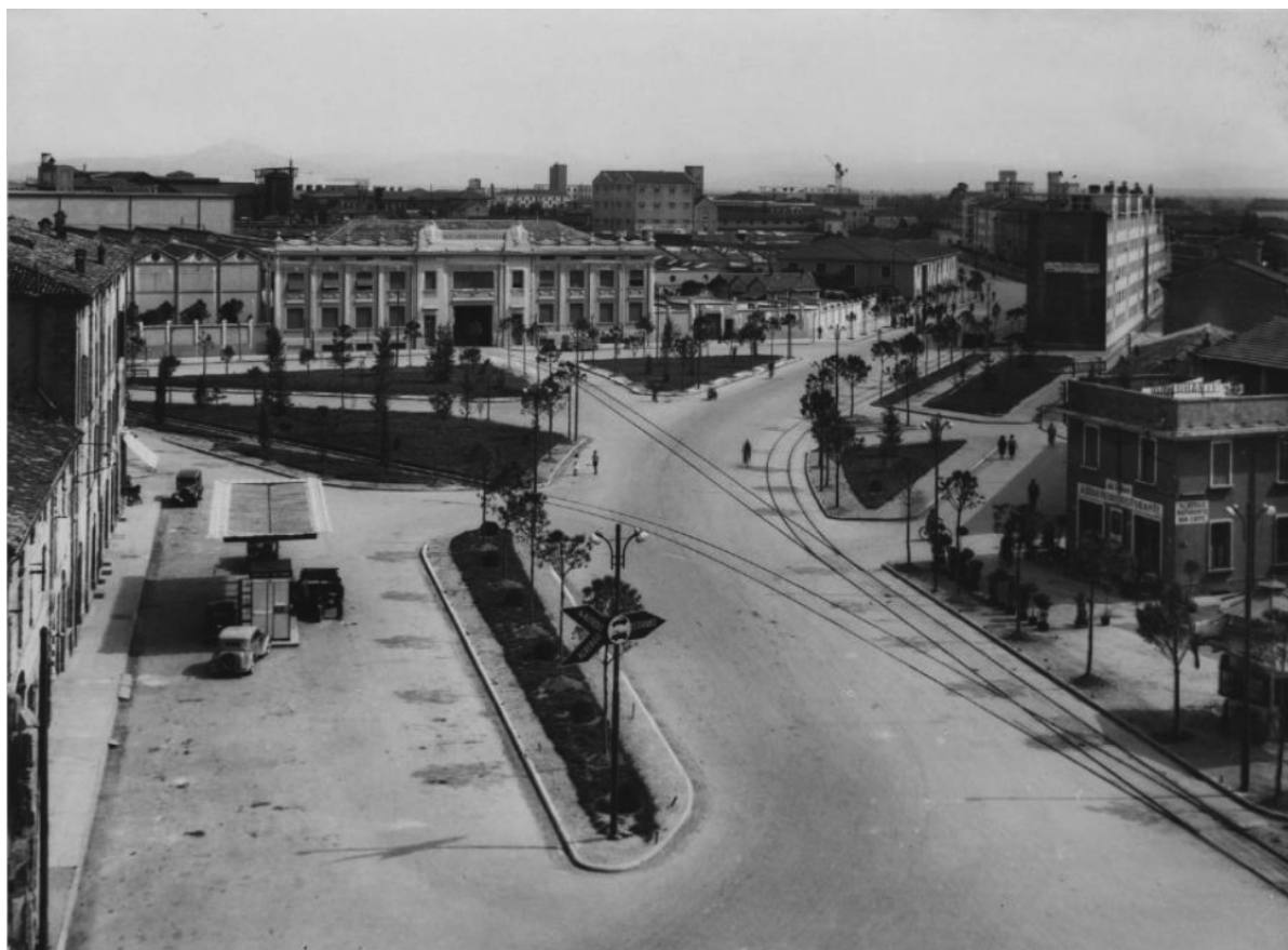
Figura 3.1: Foto dell'epoca raffigurante Piazzale Mangelli (attuale Piazzale del Lavoro), sullo sfondo l'ingresso allo stabilimento caratterizzato da un edificio a ponte, ben si notano le vecchie rotaie che si spingono fin dentro la fabbrica ( www.ResistenaMappe.it )
