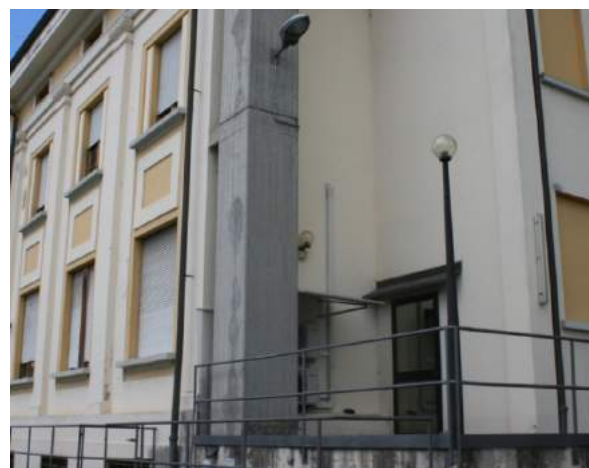
Figura 3: Foto dell'esterno dell'edificio, angolo Est. Si può notare la presenza delle macchine dell'impianto di climatizzazione con la relativa canalina di impianti e canna fumaria in cemento armato. Questo e' l'esterno della parete indagata dall'interno dell'edificio.
