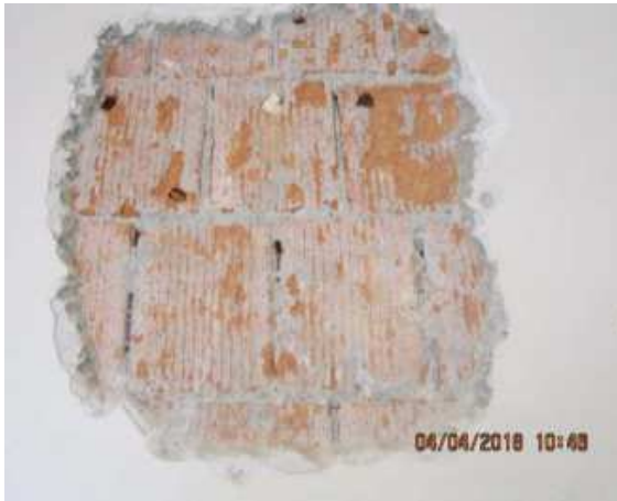
Figura 6.1: Rimozione dello strato di intonaco per messa in vista muratura (Controls)
