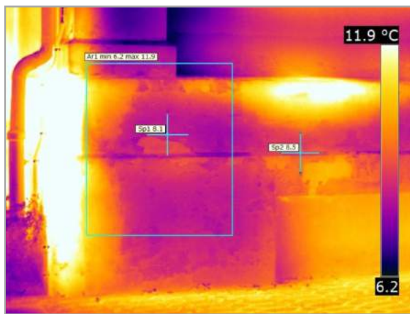
Termogramma modificato: IR_18174
