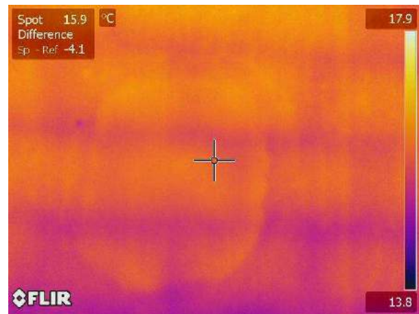
Termogramma originale: IR_18088
