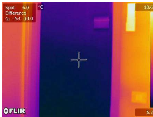
Termogramma originale: IR_18112
