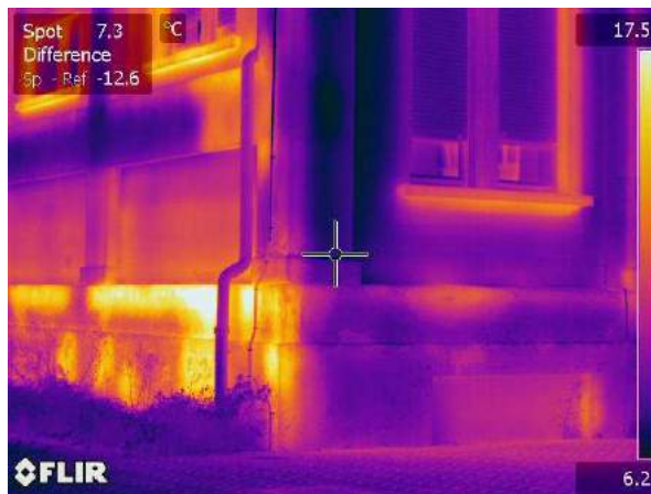
Termogramma originale: IR_18176
