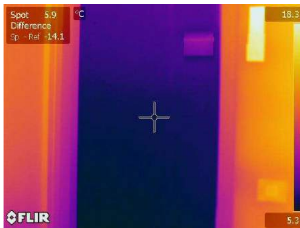
Termogramma originale: IR_18116
