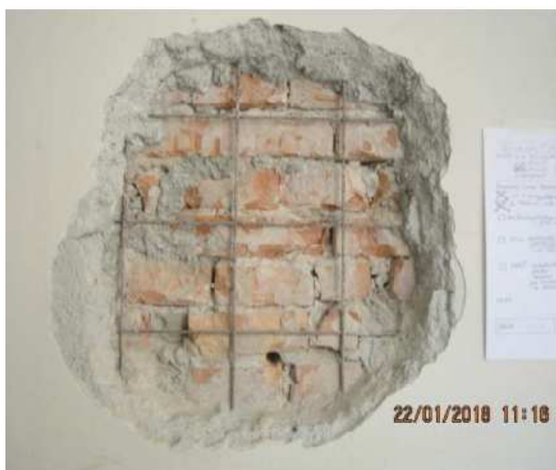
Figura 5.6: Saggio con rimozione di spesso strato di intonaco per messa in vista della muratura di laterizi della parete NE dietro a rete metallica elettrosaldata (Controls s.r.l.)
