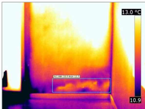
Termogramma modificato: IR_18148
