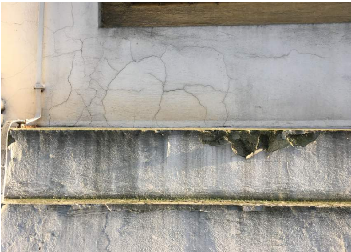
Figura 4.25: Distacco della tinteggiatura e presenza di licheni e muschio legata all'esposizione e alla presenza d alberatura
