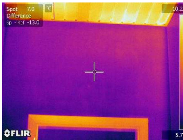
Termogramma originale: IR_18122
