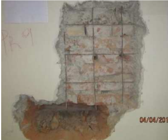
Figura 6.4: Rimozione dello strato di intonaco per messa in vista muratura e prelievo di mattone sulla muratura SO della stanza I19 (Controls)
