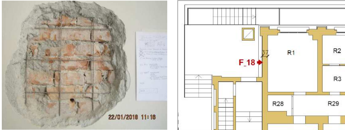
Figura 12: Saggio con rimozione di spesso strato di intonaco (a sinistra) per messa in vista della muratura di laterizi della parete NE dietro a rete metallica elettrosaldata effettuato sulla faccia interna della parete di indagata (Controls s.r.l., Gennaio 2018); a destra è riportata una porzione NE della pianta del piano rialzato con la posizione di esecuzione della linea radar F_18 e lo spessore della parete oggetto di indagine.
