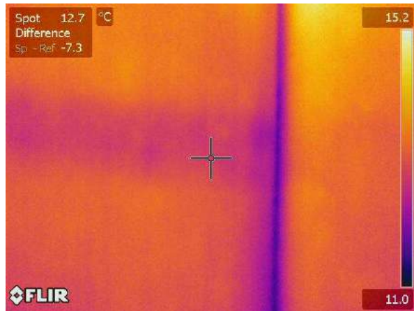
Termogramma originale: IR_18142
