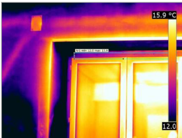
Termogramma modificato: IR_18152
