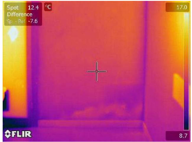
Termogramma originale: IR_18146
