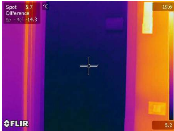
Termogramma originale: IR_18098
