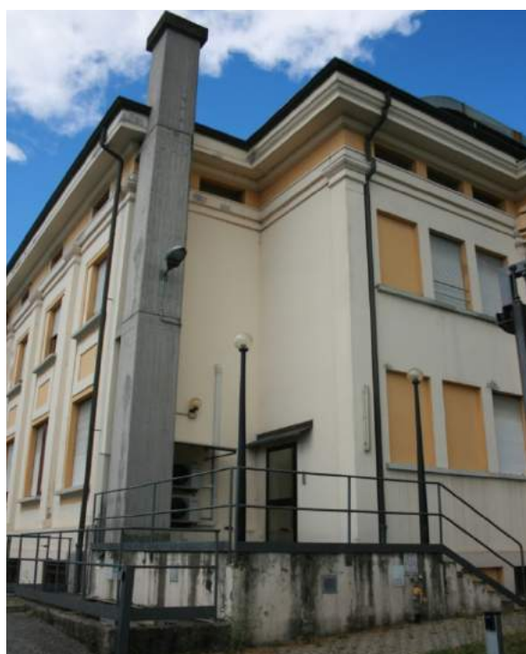
Figura 5.7: Foto dell'esterno dell'edificio, angolo Est. Si può notare la presenza delle macchine dell'impianto di climatizzazione e canna fumaria in cemento armato.
