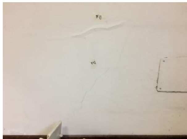
Figura 15: Fessure lievi F11 e F12, parete SO
