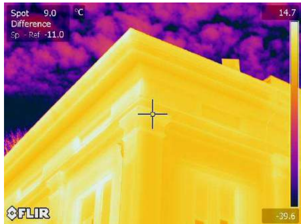
Termogramma originale: IR_18178
