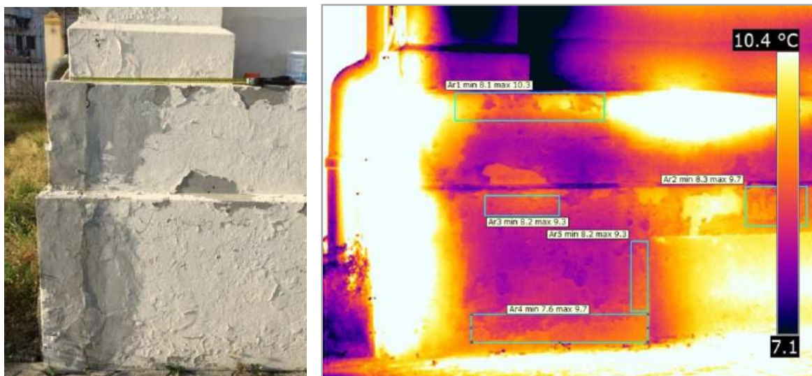
Figura 6.12: Immagine fotografica (a sinistra) della parete SE all'angolo Sud dell'edificio e termogramma IR_80174 (a destra) inquadrante circa la stessa porzione di area.
