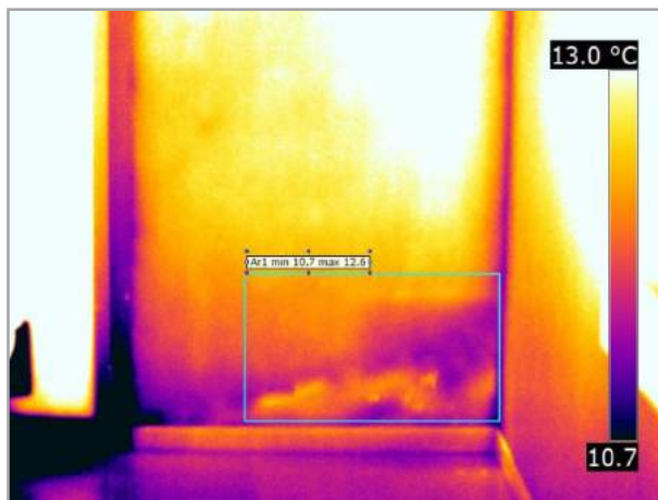
Termogramma modificato: IR_18146
