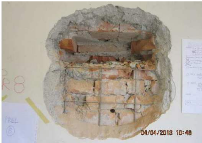
Figura 4: Saggio con rimozione di spesso strato di intonaco per messa in vista della muratura di laterizi e prelievo di mattone con manomissione anche della rete metallica elettrosaldata presente (Controls s.r.l., Aprile 2018)
