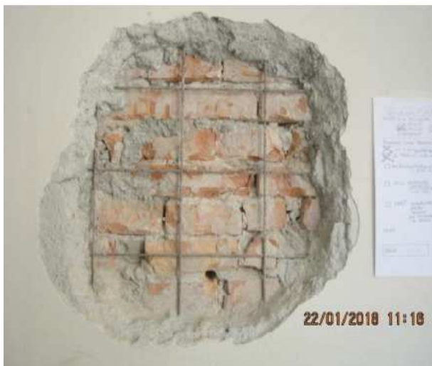
Figura 3: Saggio con rimozione di spesso strato di intonaco per messa in vista della muratura di laterizi della parete NE dietro a rete metallica elettrosaldata (Controls s.r.l.)
