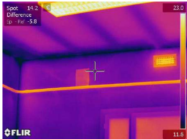
Termogramma originale: IR_18144
