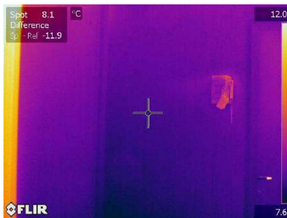
Termogramma originale: IR_18172
