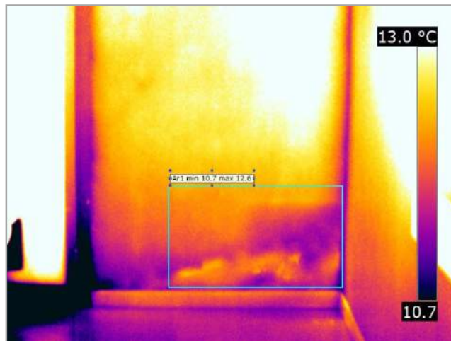
Termogramma modificato: IR_18146
