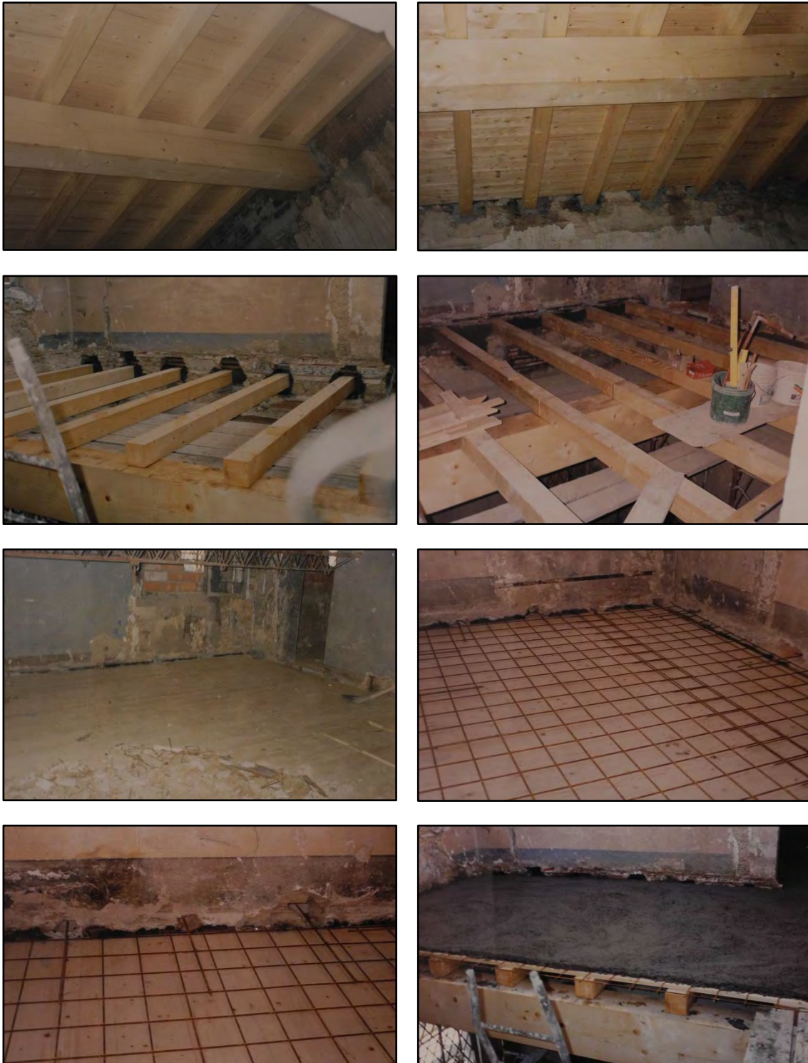
Figura 71-72-73-74-75-76-77-78: Foto dei lavori di rifacimento dei solai in legno a doppia orditura
