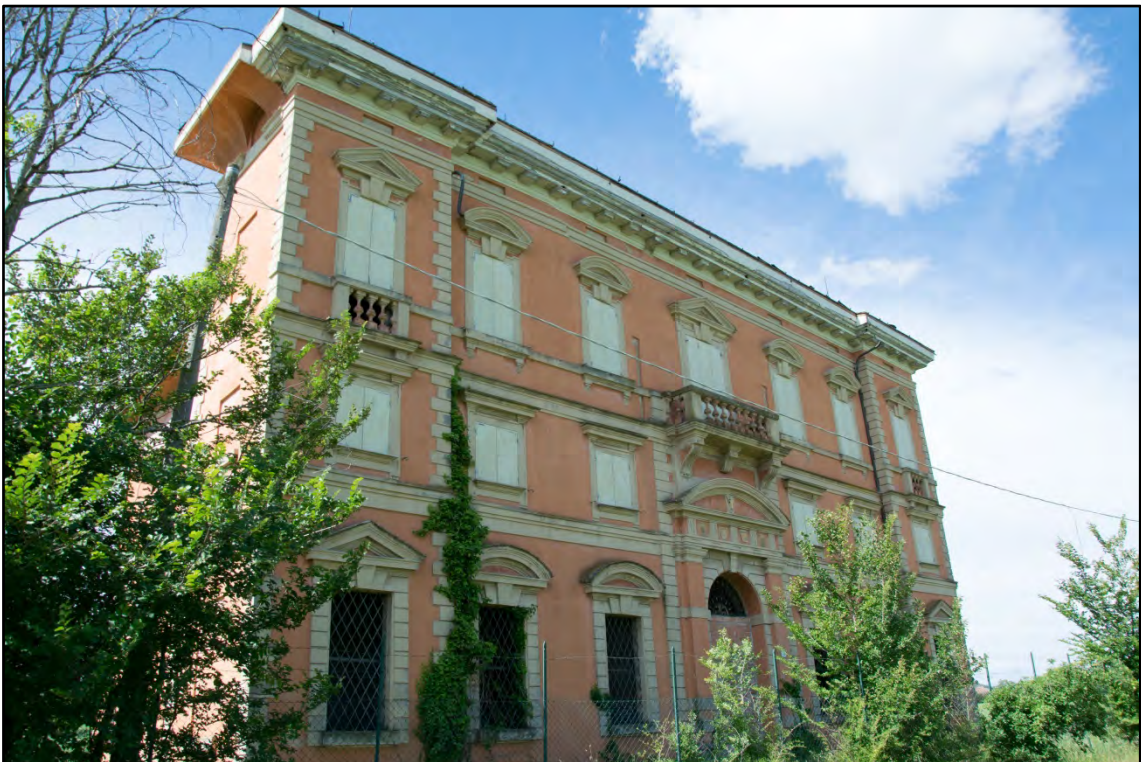
Figura 3: Vista del prospetto principale, rivolto verso Nord
