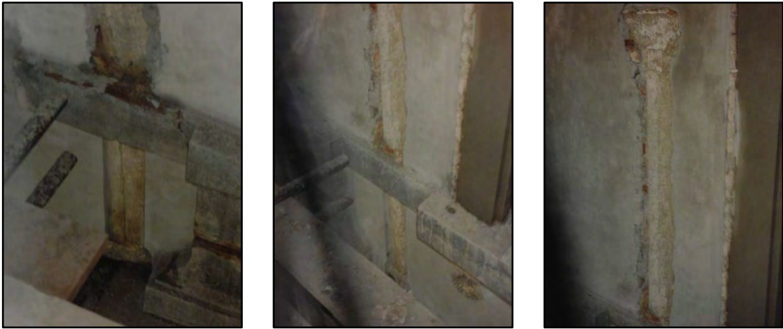
Figura 95-96-97: Foto dei lavori di ripristino delle decorazioni rovinate nei prospetti
