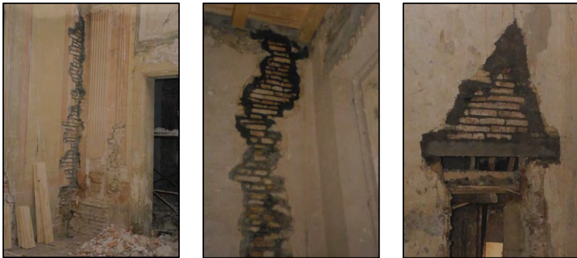
Figura 68-69-70: Foto dei lavori degli interventi di "cuci e scuci" nei paramenti murari lesionati e sostituzione dell'architrave sopra le aperture ove necessario
