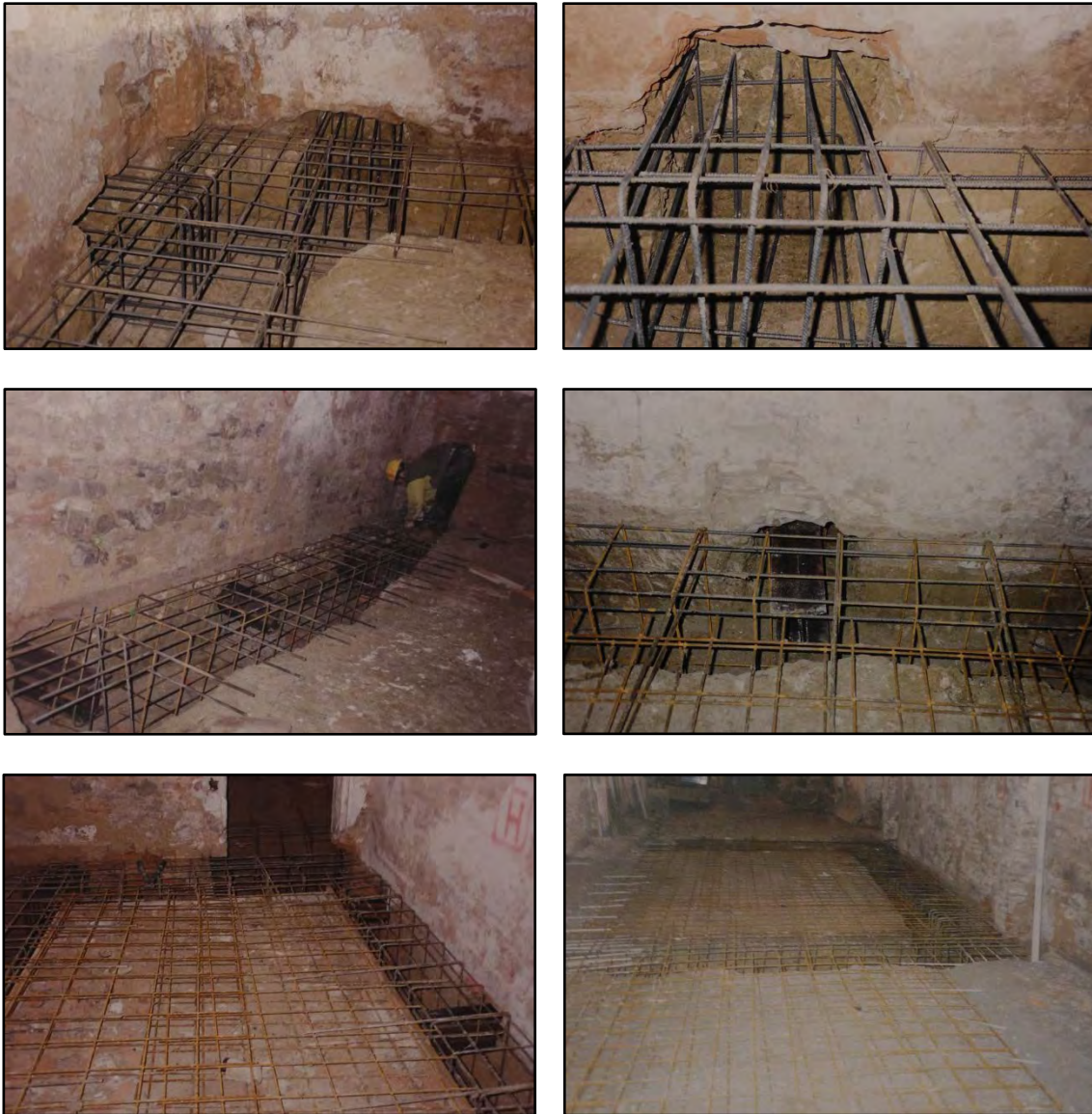
Figura 52-53-54-55-56-57: Foto dei lavori dell'installazione della nuova sottofondazione interna
