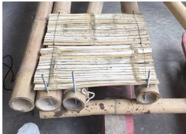
Figura 62: Posa del canniccio in guadua splittata sul prototipo costruito in questa tesi. Fonte propria
