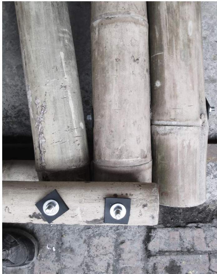
Figura 85: DET 3, Foto vista frontale
