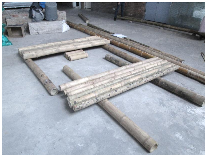
Figura 72: Taglio degli elementi costruttivi per la costruzione del primo pannello
