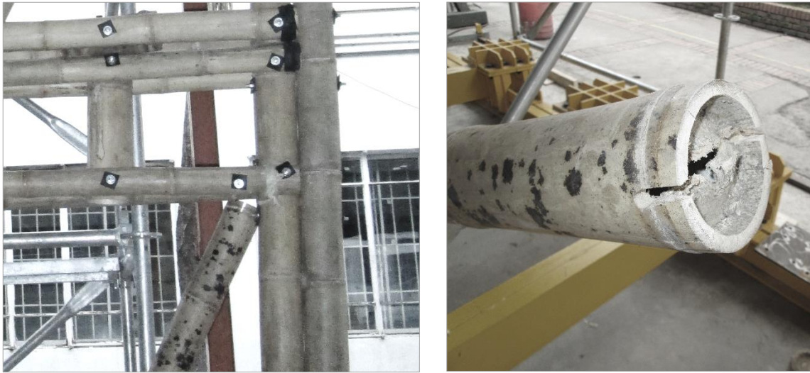
Figura 121: Foto della diagonale sganciata in corrispondenza del Nodo 1 oggetto di studio
