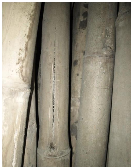
Figura 148: Foto guadua fessurata
