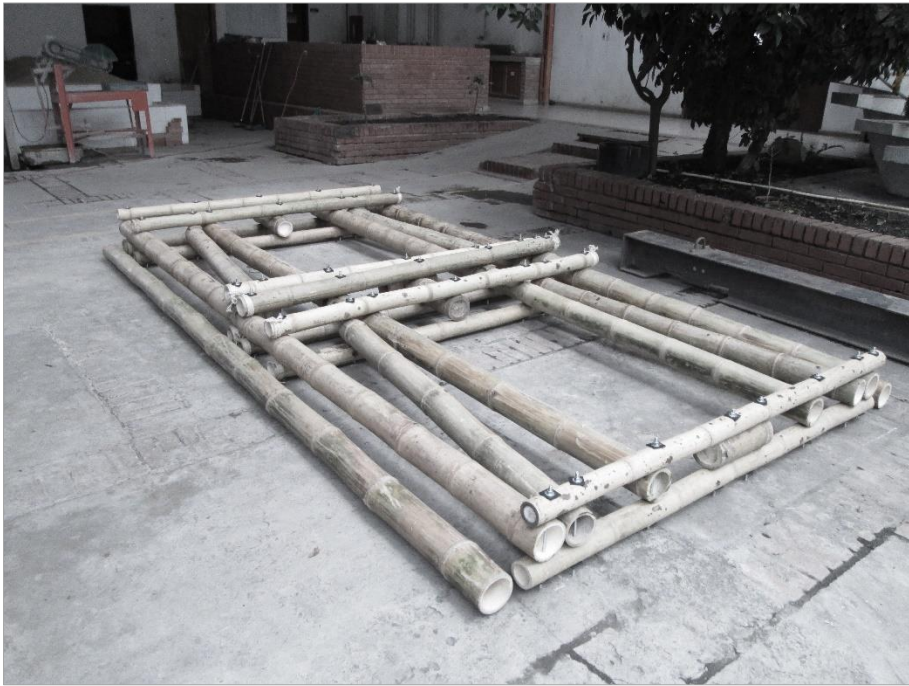
Figura 79: Foto prima dell'ancoraggio dei pannelli alle colonne portanti a doppia altezza
