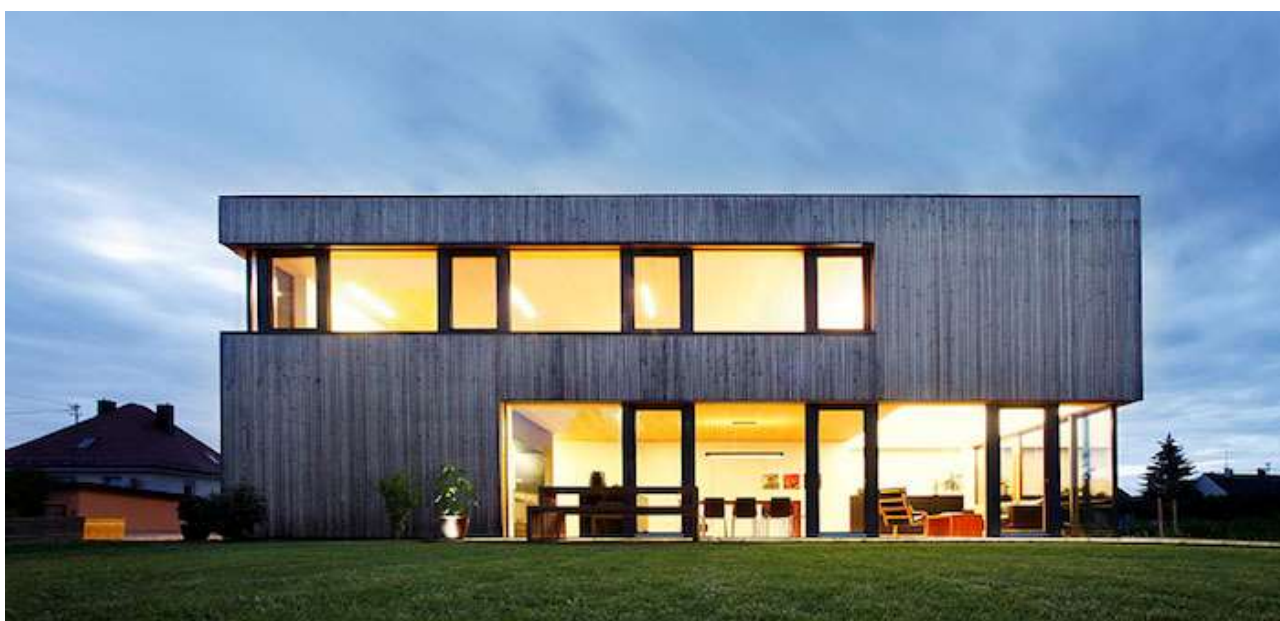
Figura 2 Casa passiva con vetrate esposte a sud
