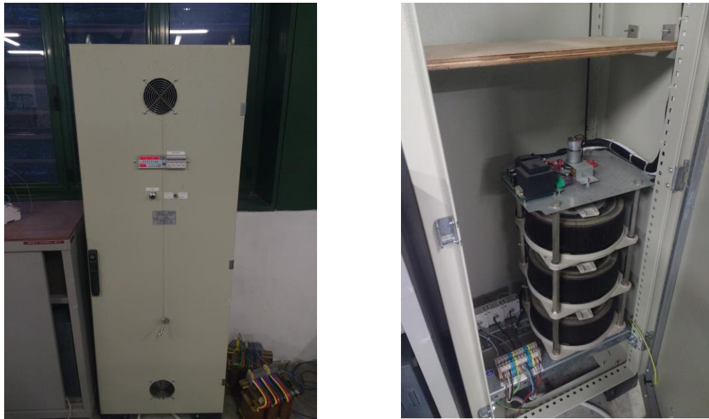
Figura 5.21 – Variac di alimentazione dell'inverter A. Vista esterna (sinistra) e vista interna (destra).
