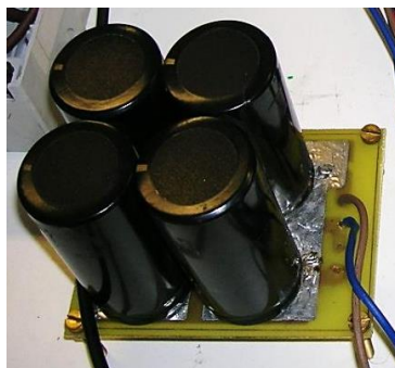
Figura 5.27 – Bus DC dell'inverter B.
