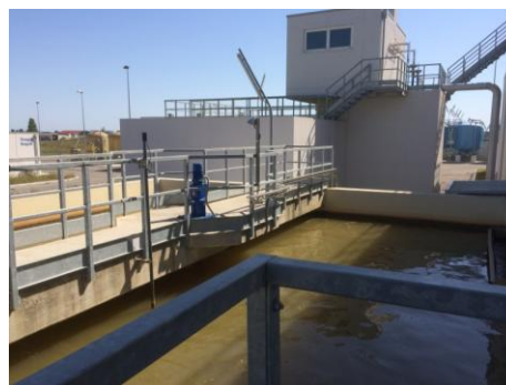
Figura 1.18 Vasca di flocculazione
