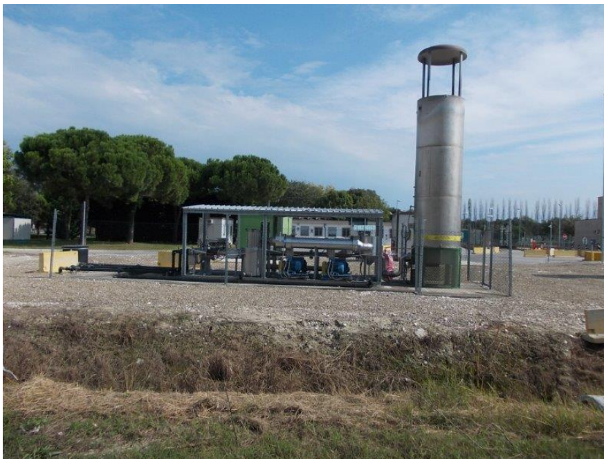
Figura 5 Stazione di aspirazione del biogas dal corpo discarica e torcia ad alta temperatura.
