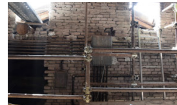
Fig. 39 Muro esterno dell'abside della chiesa visto dal sottotetto della chiesa stessa. L'ambiente che si intravede dall'apertura in basso a sinistra è il sottotetto dell'oratorio, mentre le due falde inclinate, visibili dalle aperture superiori della parete, ne costituiscono la copertura.
