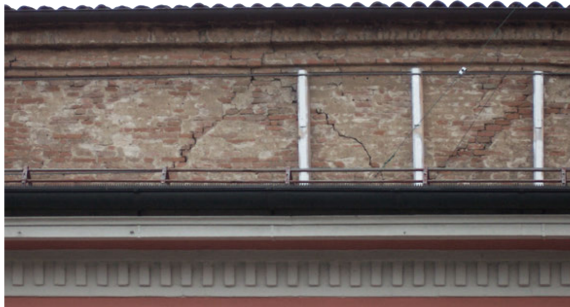
Fig. 58 Lesioni sulla parete nord - est dell'oratorio, al di sopra della copertura dell'edificio privato ad esso addossato. Le lesioni si manifestano prevalentemente lungo i giunti di malta, la loro presenza è dovuta probabilmente alla non corretta esecuzione di interventi di scuci e cucì passati.
