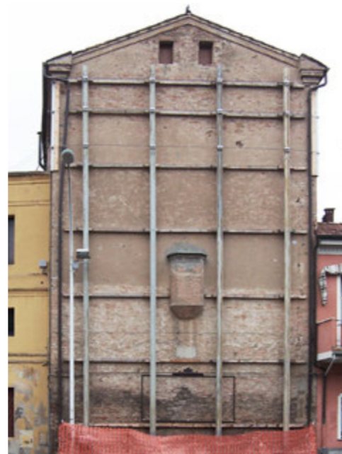
Fig. 53 Opere provvisorie realizzate sulla facciata nord-ovest dell'oratorio, su via Foro Boario.
