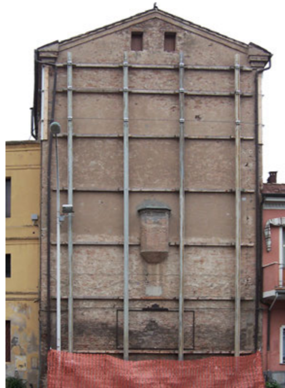
Fig. 100 Prospetto nord - ovest dell'oratorio, su via Foro Boario. Sulla superficie muraria sono visibili le porzioni recanti le tracce di un'intonacatura passata e, in basso, il degrado dovuto alla presenza di croste nere ed umidità.
