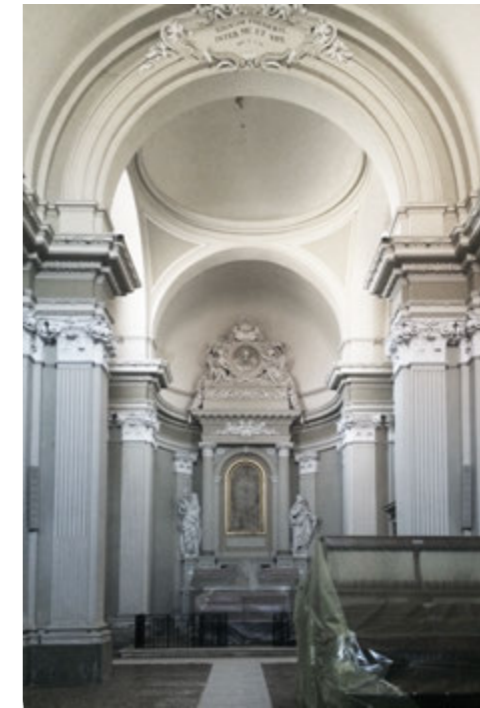
Fig. 44 Interno della chiesa della Beata Vergine della Cintura. E' possibile osservare il controsoffitto voltato che adorna la chiesa.
