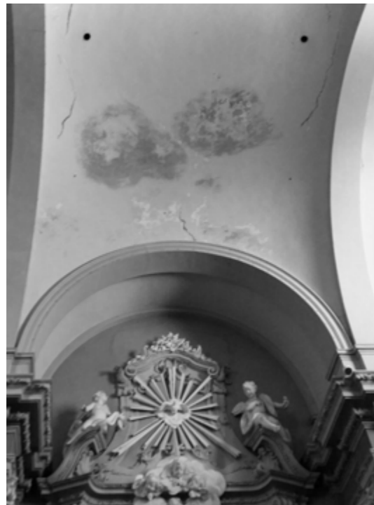
Fig. 65 Lesione nella volta a vela della navata centrale della chiesa, in prossimità dei due altari laterali.
