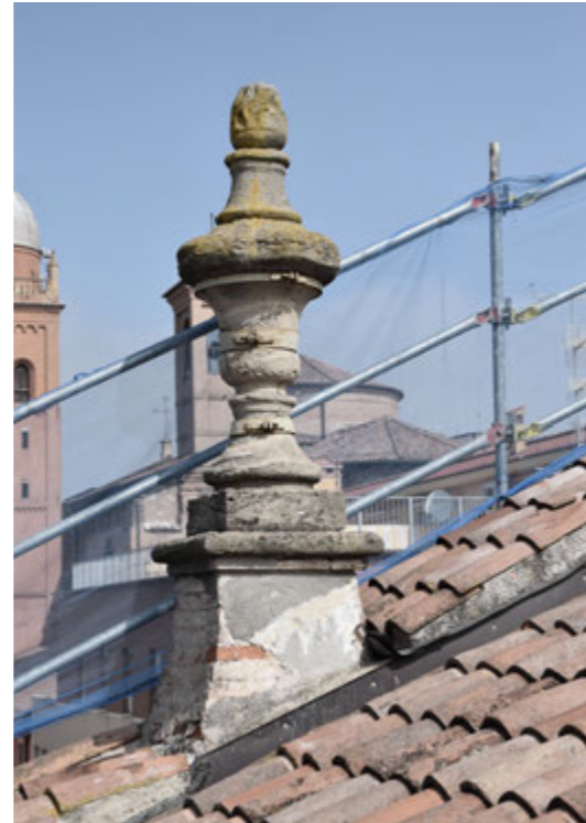
Fig. 71 Guglia sommitale laterale della facciata su piazza Garibaldi. Si osserva l'intonaco parzialmente scrostato sul basamento in laterizio e il degrado del materiale lapideo soprastante dovuto in particolar modo alla presenza di numerose efflorescenze saline.
