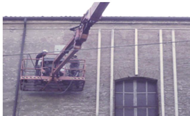
Fig. 54 Fase di montaggio delle opere provvisorie sul prospetto nord-est dell'edificio, in prossimità di una finestra.
