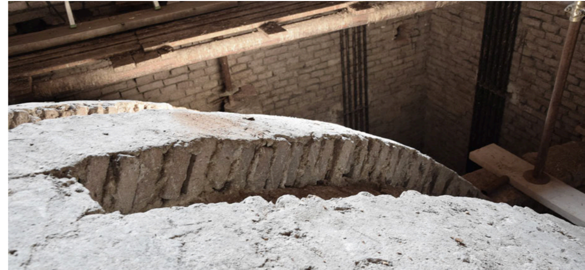
Fig. 48 Dettaglio di una delle nervature della volta dell'abside dove è possibile osservare la disposizione dei mattoni.
