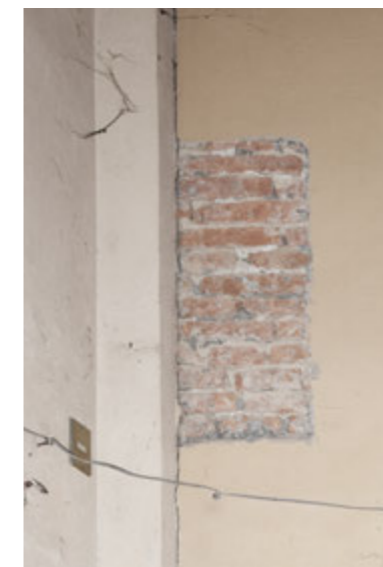
Fig. 63 Particolare della lesione interna sulla parete nord-ovest dell'oratorio. Fase di rimozione dell'intonaco in prossimità della lesione.
