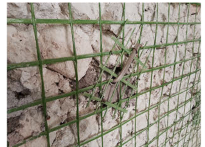
Immagine esemplificativa dell'intervento con rete GFRP.
