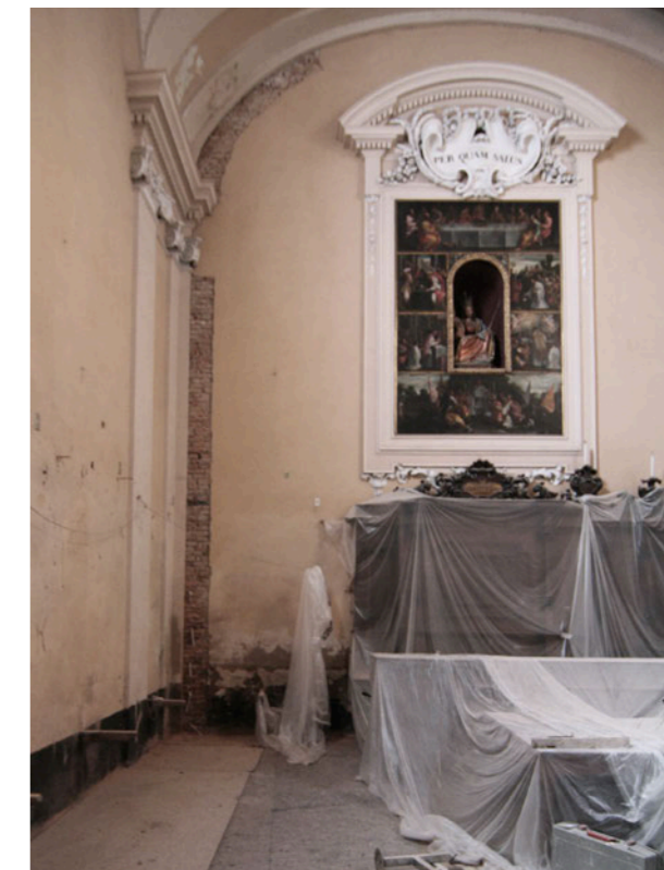
Fig. 88 Parete nord - ovest dell'oratorio in seguito alla parziale rimozione dell'intonaco in prossimità dello spigolo nord. A fianco, il coro smontato in e protetto per permettere l'esecuzione dei lavori.
