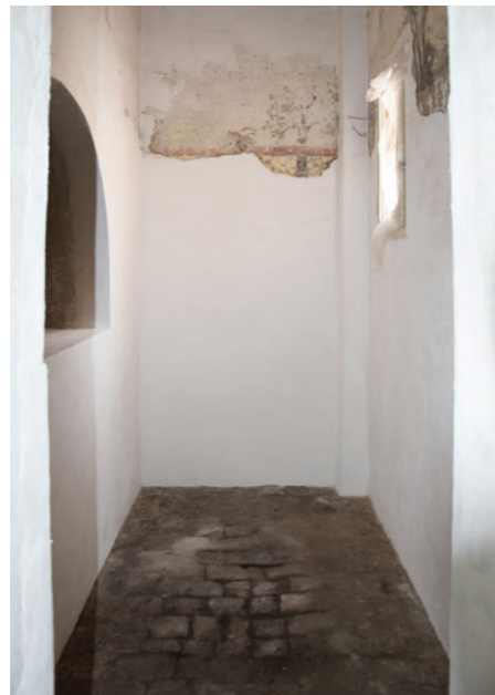
Fig. 84 Aspetto del locale in seguito alla demolizione del pavimento.
