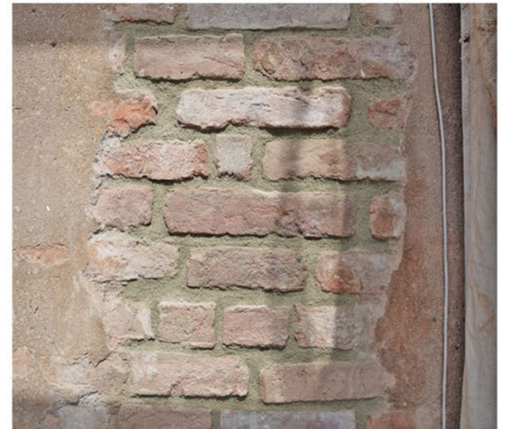
Foto della porzione di muratura lesionata dopo la realizzazione dello scuci e cuci.
