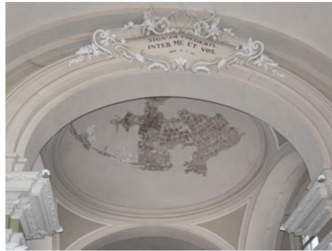
Fig. 77 Cupola della navata centrale durante la fase di apertura delle lesioni.
