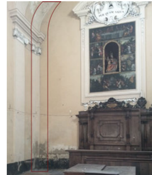
Fig. 62 Lesione lungo il perimetro della parete interna nord-ovest dell'oratorio. In rosso è evidenziata la porzione di muratura d'angolo interessata dalla lesione.
