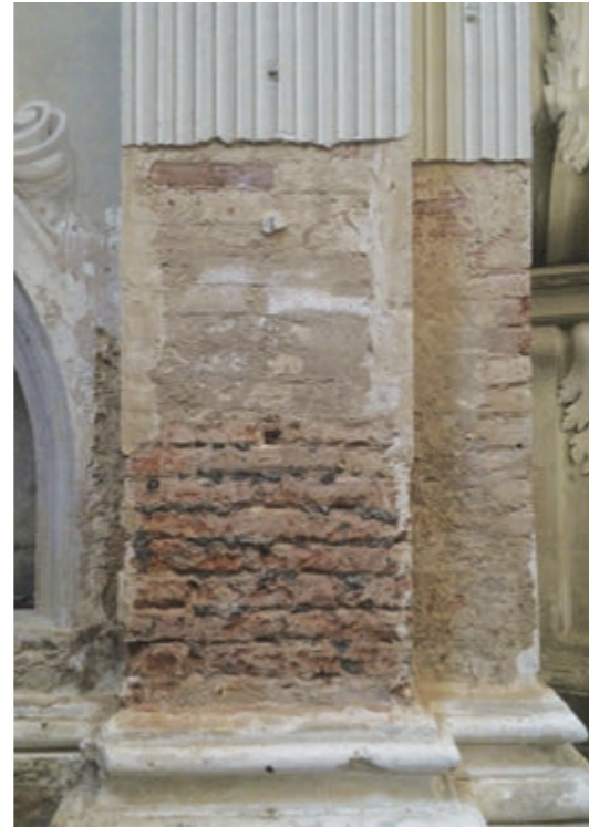
Fig. 68 Umidità di risalita sulle colonne della parete nord - est della chiesa. Anche in questo caso l'elevato livello di degrado dei materiali sottostanti, oltre che dell'intonaco, è evidente e diffuso.
