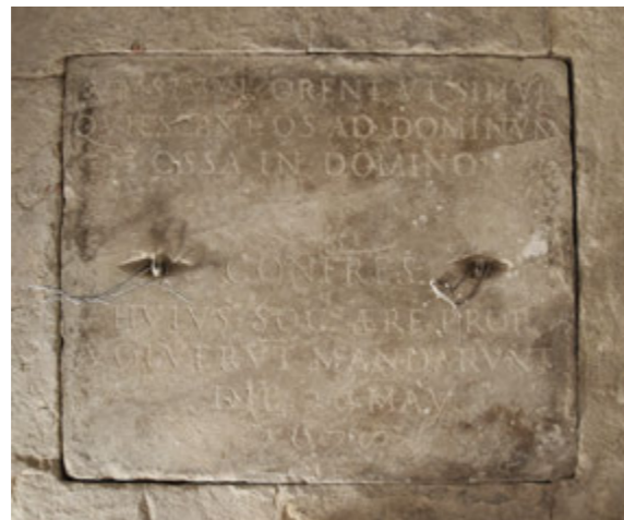
Fig. 25 Botola dell'ossario situato nel corridoio sud-ovest di collegamento tra il corpo principale della chiesa e il retrostante oratorio. La botola reca la data del 1678.
