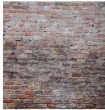
Foto di una porzione di muratura nella zona inferiore.
