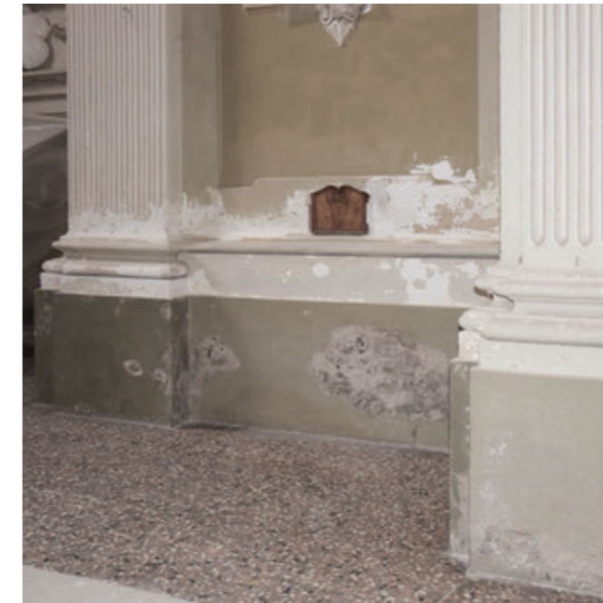
Fig. 66 Umidità di risalita alla base delle murature perimetrali della chiesa, in particolare sul lato nord - est. Il fronte di risalita si estende fino a raggiungere, in alcune parti, un'altezza di circa 2 metri.
