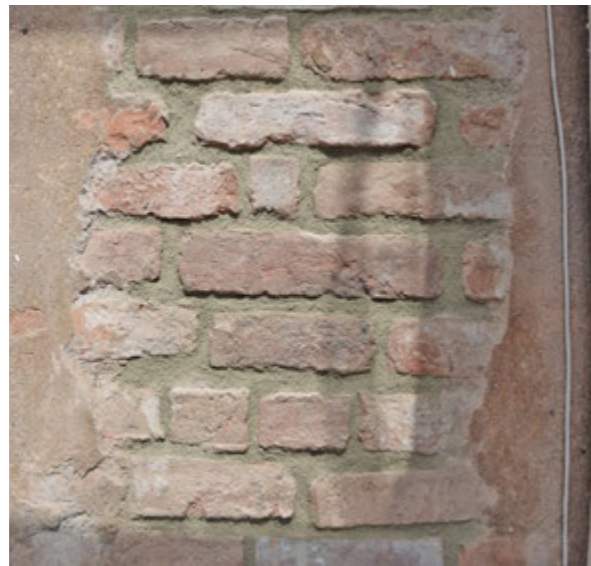
Fig. 74 Porzione di muratura della parete nord - ovest dopo l'intervento di scuci e cuci della lesione.
