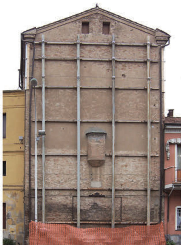
Lesioni sul prospetto nord - est
