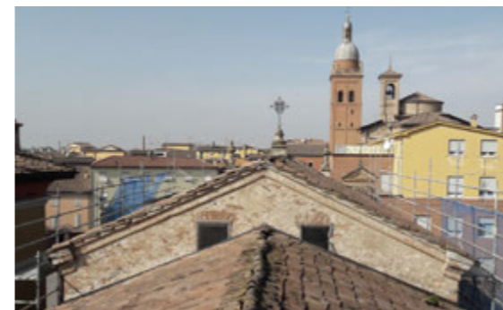
Fig. 38 Muro esterno dell'abside della chiesa visto dal tetto dell'oratorio. La parete separa la navata principale dal volume dell'oratorio retrostante costituendo l'unico controventamento interno dell'edificio.
