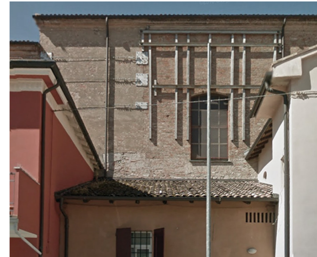
Fig. 42 Particolare del prospetto nord est su piazzetta Guazzatoio. Dalla foto sono visibili i segni di una probabile sopraelevazione della chiesa, della chiusura di una precedente apertura al di sotto di quella attuale e della linea verticale di giunzione tra il volume originario della chiesa e l'ampliamento di fine '700.
