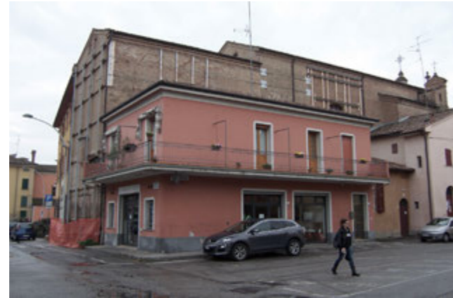
Fig. 40 La Chiesa della Beata Vergine della Cintura vista dall'incrocio tra via Foro Boario e Piazzetta Guazzatoio. La facciata che presenta caratteri di forte vulnerabilità è quella retrostante dell'oratorio, su via Foro Boario.
