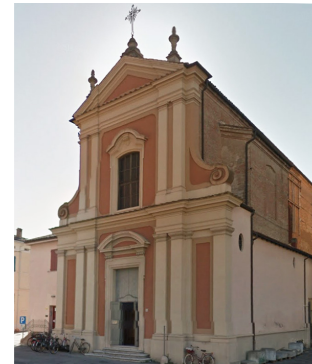
Fig. 59 Facciata principale della Chiesa della Beata Vergine della Cintura, posta a sud - est su piazza Garibaldi. La facciata non ha riportato lesioni in seguito al sisma del maggio 2012.
