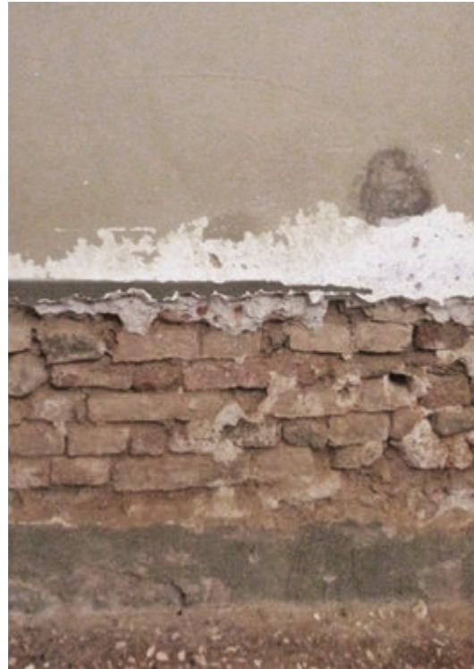
Fig. 67 Umidità di risalita alla base delle mura- ture perimetrali della chiesa, in particolare sul lato nord -est. I mattoni e i ciottoli che costitu- iscono il paramento sono fortemente compro- messi e saturi d'acqua.
