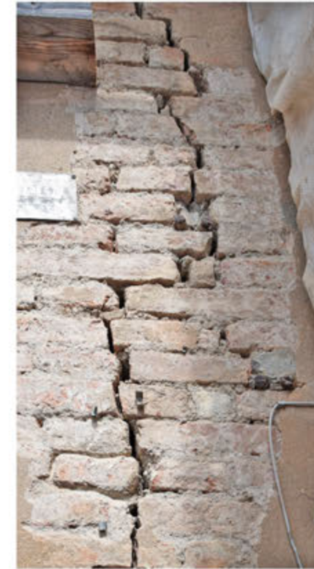
Foto della lesione verticale dopo la preparazione del supporto.
