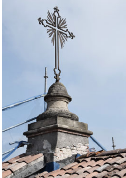
Fig. 70 Guglia sommitale posta al centro della facciata su piazza Garibaldi. Si osserva l'intonaco parzialmente scrostato sul basamento in laterizio e il degrado del materiale lapideo soprastante.
