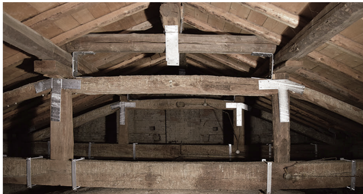
Fig. 80 Intervento di ripristino delle connessioni degli elementi della capriata.
