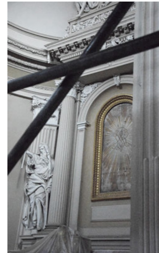
Fig. 81 I decori in stucco a scagliola dell'altare maggiore al di là della struttura del ponteggio. In primo piano l'effetto pittorico delle scanalature di una colonna. Dietro, la statua in gesso di Mosè, opera di Giacomo De Maria.
