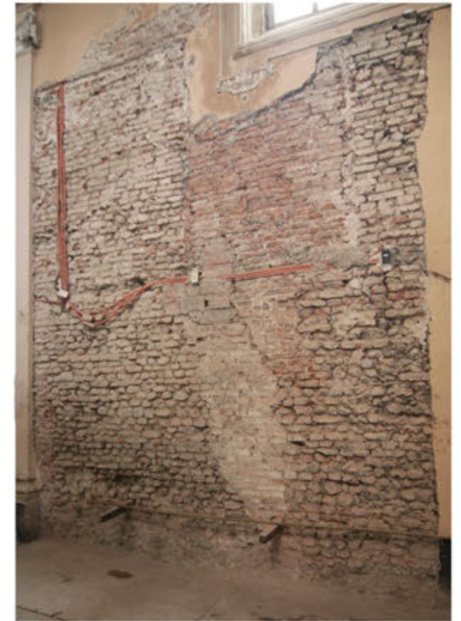
Foto della parete interna all'oratorio, lato nord - est, dopo la rimozione dell'intonaco.
