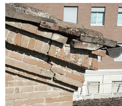
Fig. 97 Lesione sul cornicione d'angolo della canonica. La lesione è dovuta allo scivolamento dei laterizi che lo compongono.
