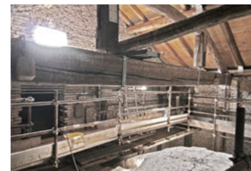
Fig. 90 Ambiente del sottotetto in seguito alle operazioni di pulizia e messa in sicurezza.
