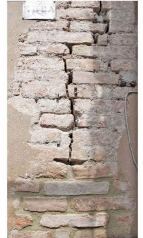
Foto dell'avanzamento dell'operazione di scuci e cuci, dal basso verso l'alto.
