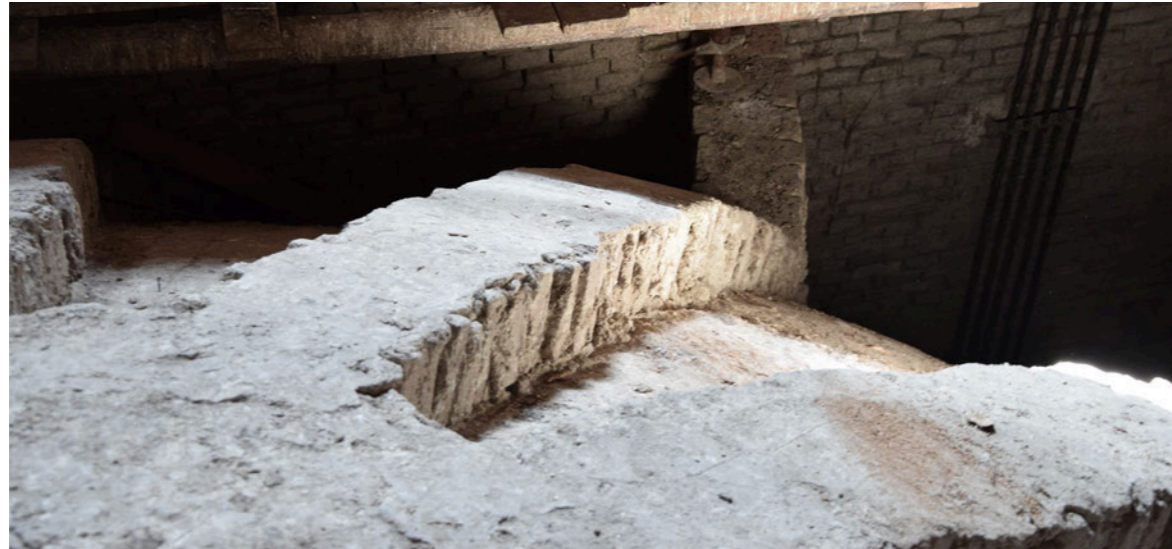
Fig. 46 Dettaglio della volta di copertura della zona absidale della chiesa; sono visibili le nervature di rinforzo all'estradosso e i rinfianchi, o frenelli, tra il muro e la struttura della volta.
