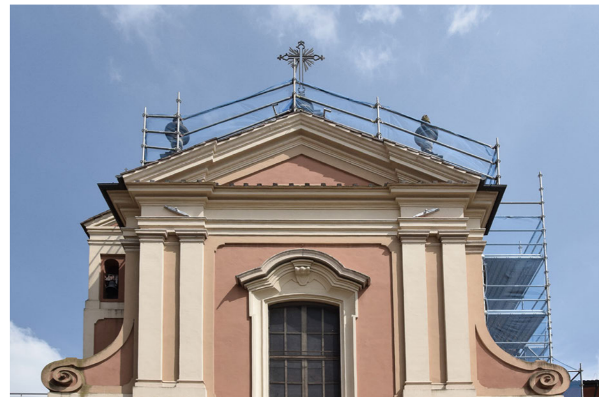
Fig. 76 Capochiave a paletto della facciata principale della chiesa, su piazza Garibaldi.
