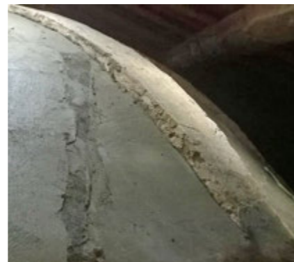
Fig. 78 Applicazione della rete in GFRP all'estradosso della cupola.
