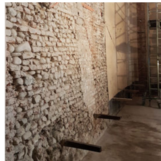
Fig. 86 Parete nord - est interna all'oratorio dopo la rimozione dell'intonaco.
