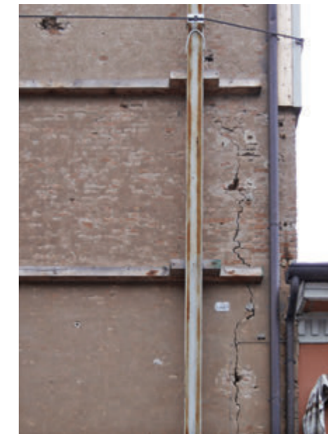
Fig. 55 Lesione verticale del prospetto nord-ovest dell'oratorio, su via Foro Boario.
