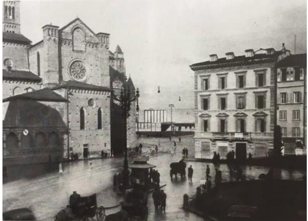
Figura 10 Vista su piazza dell'Unità Italiana, 1938
