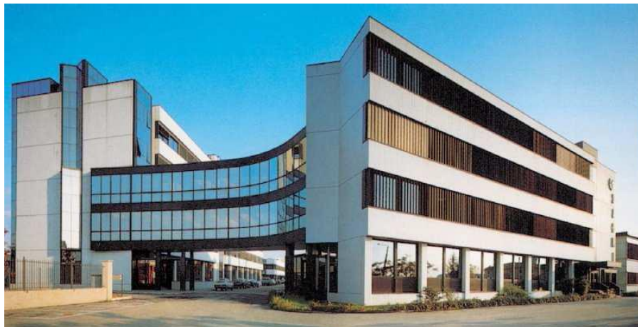
Figura 2 - Sede attuale Sacmi SC
