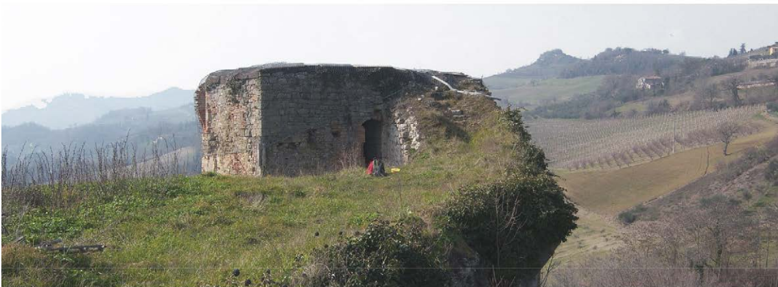
Vista del piano superiore del Mastio
