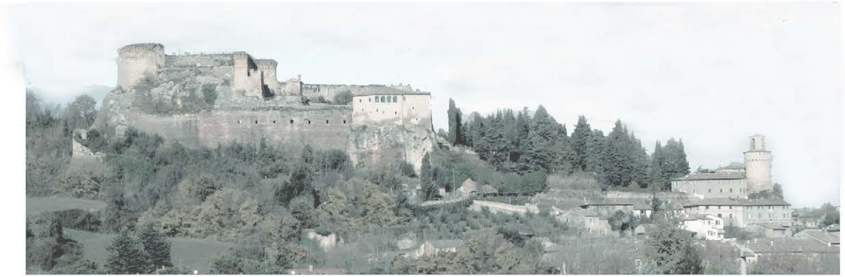
Vista del prospetto Sud della rocca
