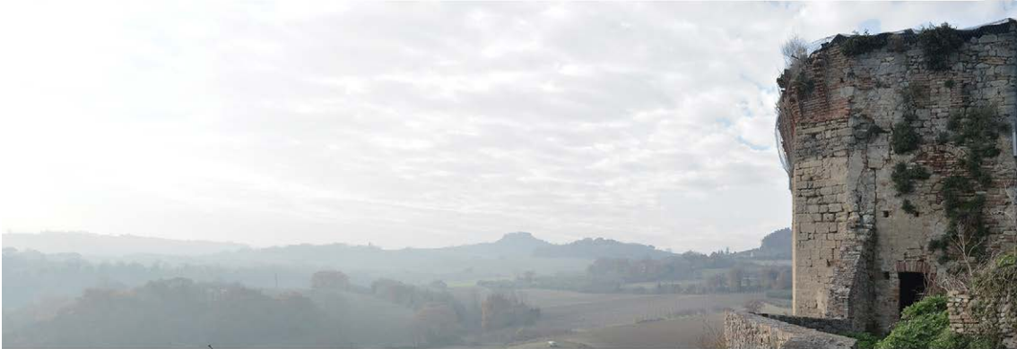
Vista dell'accesso al Mastio
