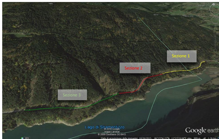
Fig. 8 - Immagine dei tre tratti analizzati lungo strada SS612 (Google Earth)
