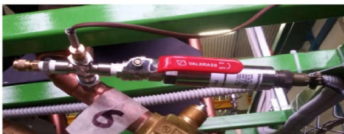
Figura 38 - Presa di misura nell'impianto ORC
