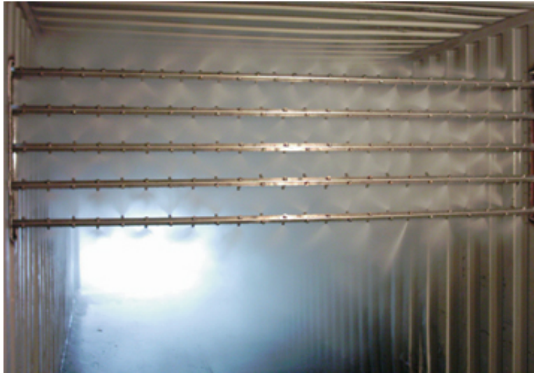
Figura 4.8: Schiera di ugelli posizionati sull'imbocco di una turbina per la produzione di energia elettrica.
