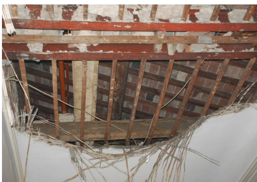
Fig.49 –Travi in legno non ispezionabili poiché coperte da controsoffitto (firenze.repubblica.it)
