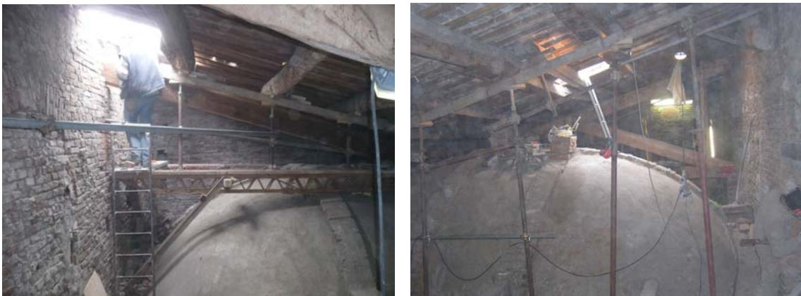
Fig.53 Fig.54– Volte in gesso nel sottotetto della chiesa del Carmine a Imola che rendono molto difficoltosa ogni operazione (fonte P.M.V.C)
