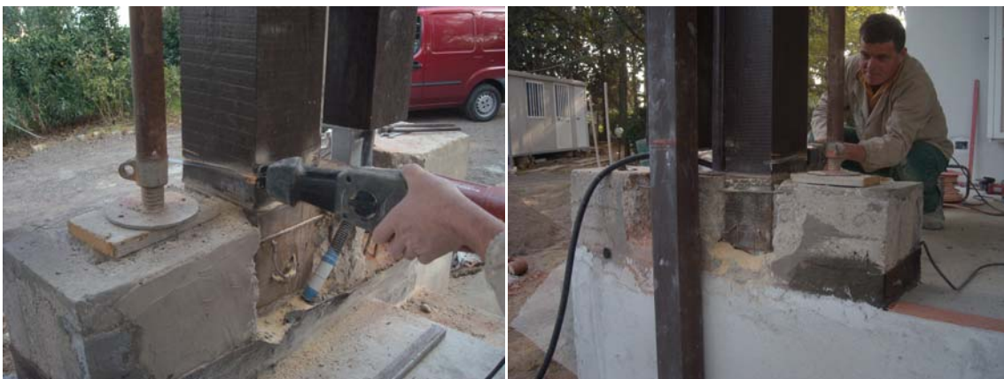
Fig.65 Fig.66- Taglio mediante sega elettrica della parte ammalorata (P.M.V.C.)
