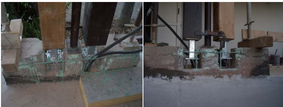
Fig.77- Trattamento passivante dei ferri (fonte P.M.V.C)
