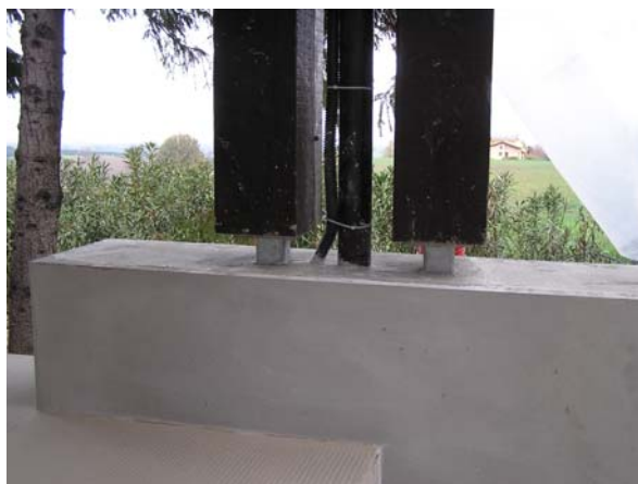
Fig.84- Lavoro di ripristino ultimato (fonte P.M.V.C.)
