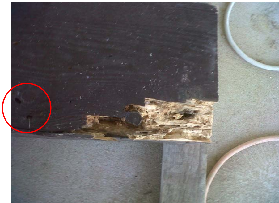
Fig.69- Parte di legno colpita dal coleottero capricorno delle case in cui è ben visibile il foro di sfarfallamento cerchiato in rosso (fonte P.M.V.C.)
