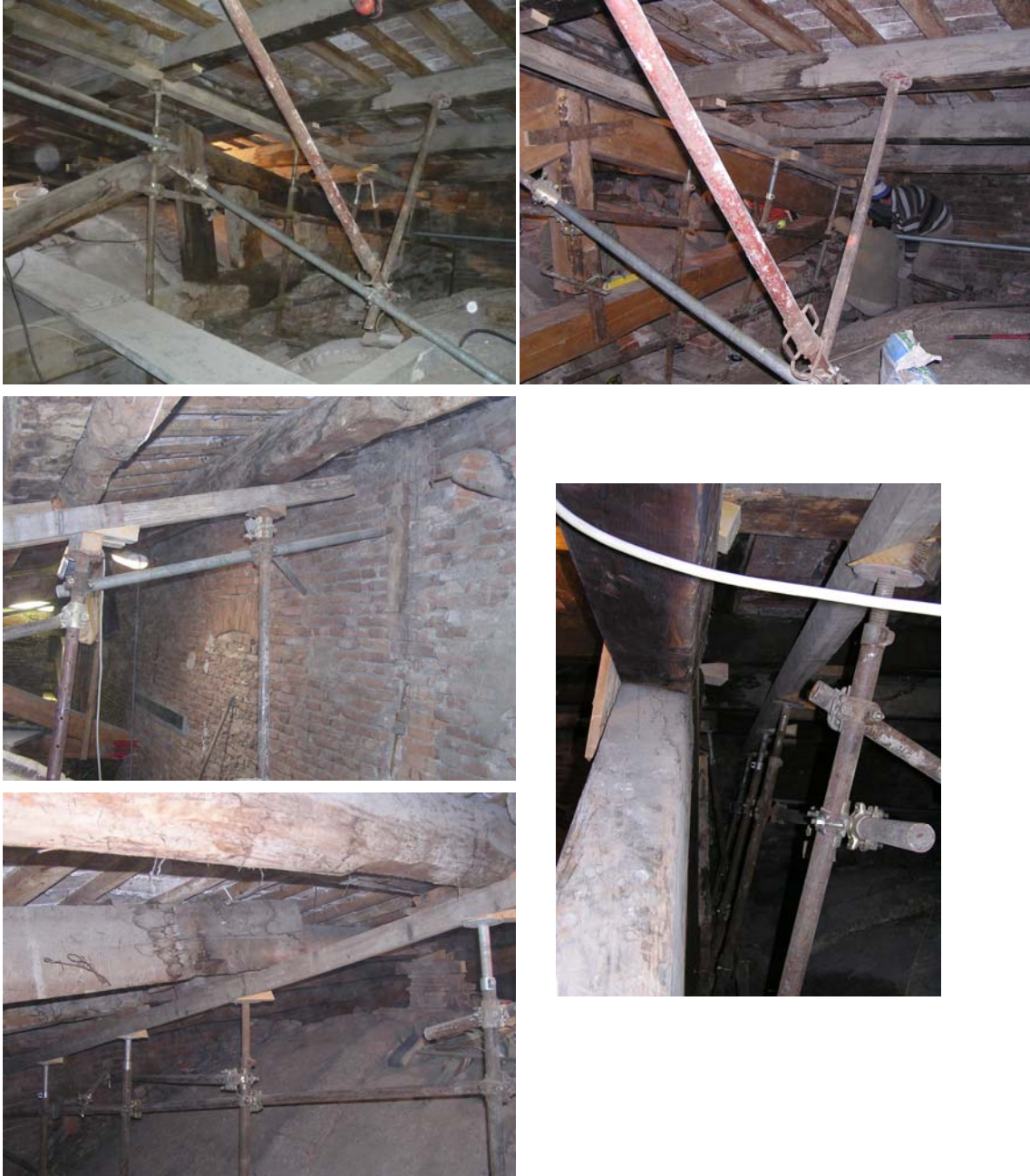
Fig.91 Fig.93 Fig.94- Messa in sicurezza della struttura mediante tubi innocenti inseriti dove possibile evitando le volte (fonte P.M.V.C.)
