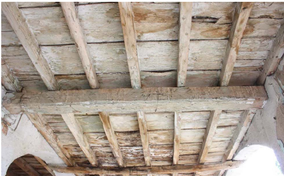
Fig.26 – Solaio evidentemente degradato (www.gruppoburraco.it)
