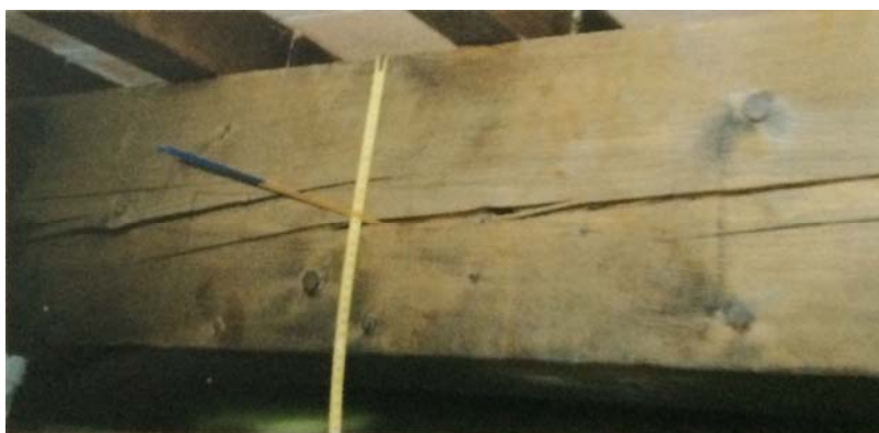
Fig.56- Utilizzo di una lamina di acciaio per verificare lo stato di fessurazione della trave (l manuale del legno strutturale)
