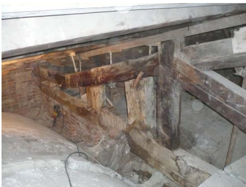
Fig.89 Fig.90- Capriata ammalorata che presenta un notevole abbassamento del puntone e la presenza di ometti in legno per sostenerlo (fonte P.M.V.C.)
