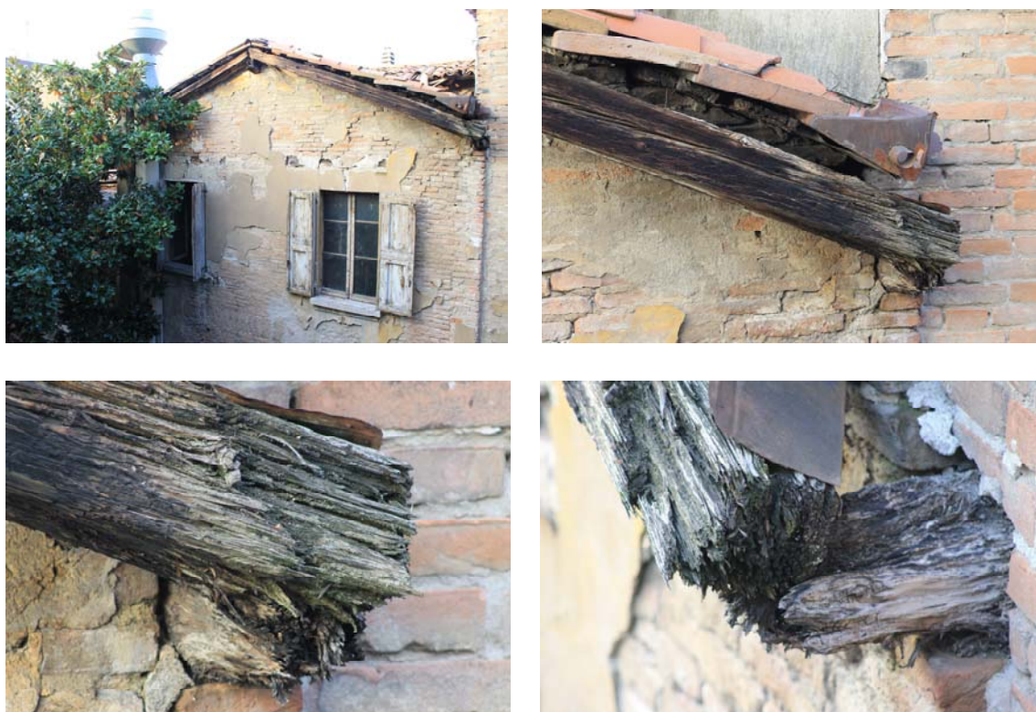
Fig.25 – Trave molto degradata a causa della sua esposizione alle intemperie al punto da perdere completamente la sua funzione strutturale (Fonte propria)
