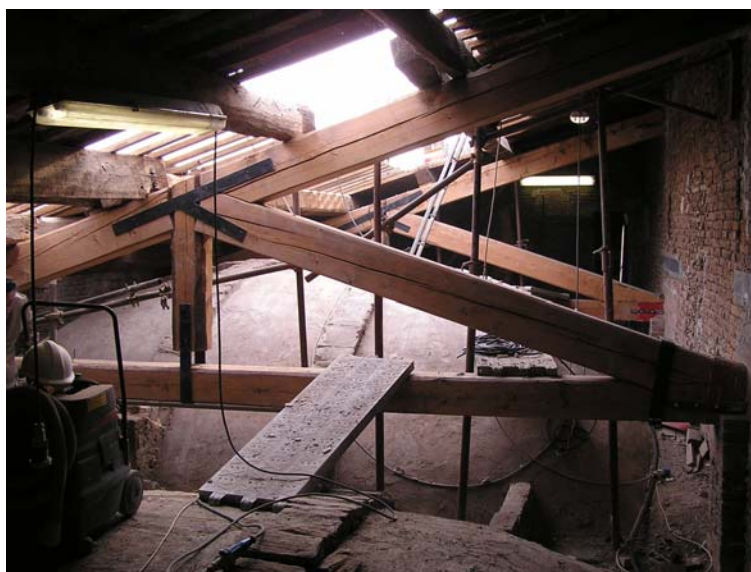
Fig.102- Capriate rinforzate da fasciature metalliche (fonte P.M.V.C.)
