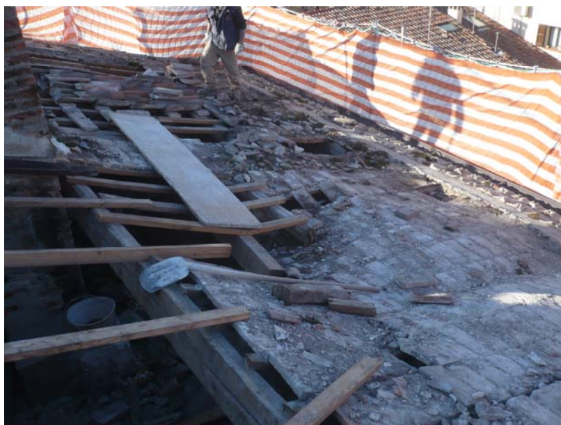
Fig.85- Avvallamento della copertura ben visibile dopo l'asportazione del manto di copertura (fonte P.M.V.C.)
