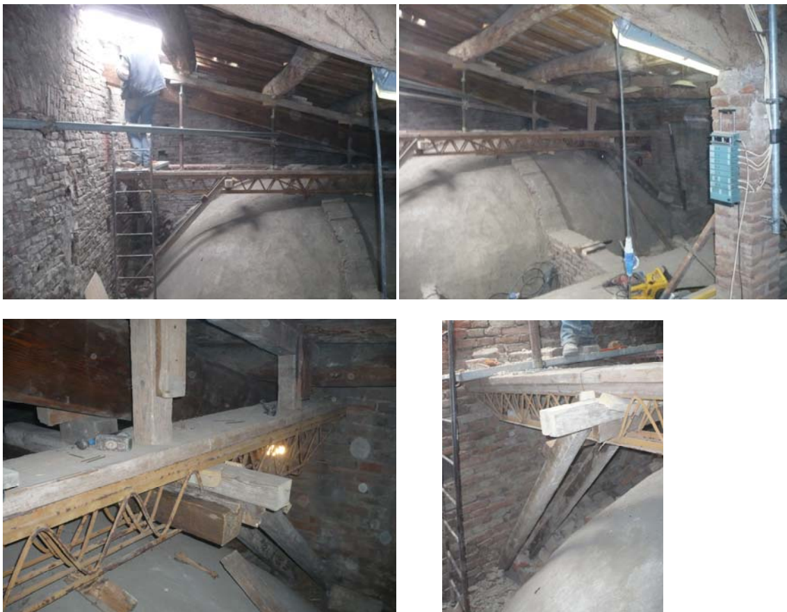
Fig.95 Fig.96 Fig.97- Impalcato per meglio eseguire la sostituzione del puntone (fonte P.M.V.C.)
