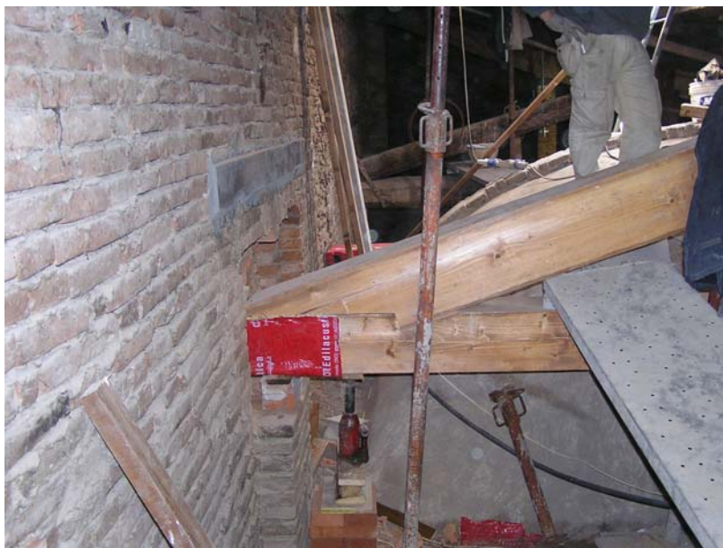
Fig.101- Collegamenti della capriata eseguiti a regola d'arte (fonte P.M.V.C.)
