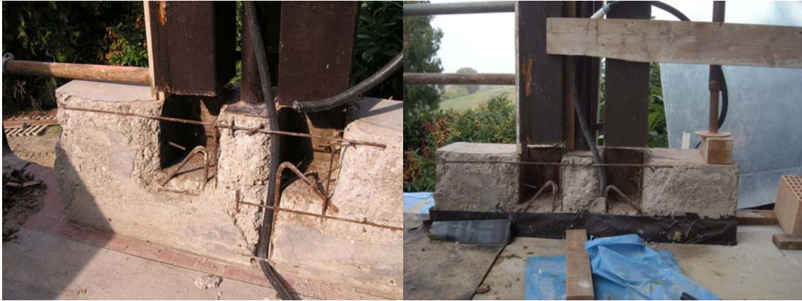
Fig.70 Fig.71- Pilastri dopo l'asportazione della parte ammalorate (fonte P.M.V.C.)
