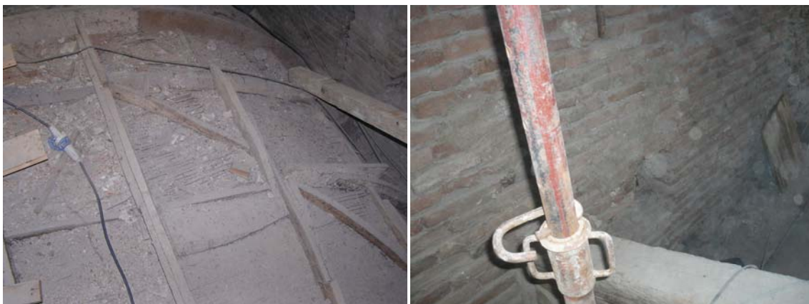
Fig.86 Fig.87 Detriti e sporcizia presenti nel sottotetto (fonte P.M.V.C.)
