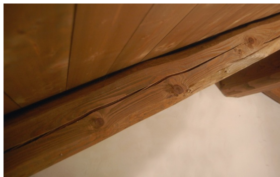
Fig.17- Fessura da ritiro su una trave in opera ( www.ingegneri.info )
