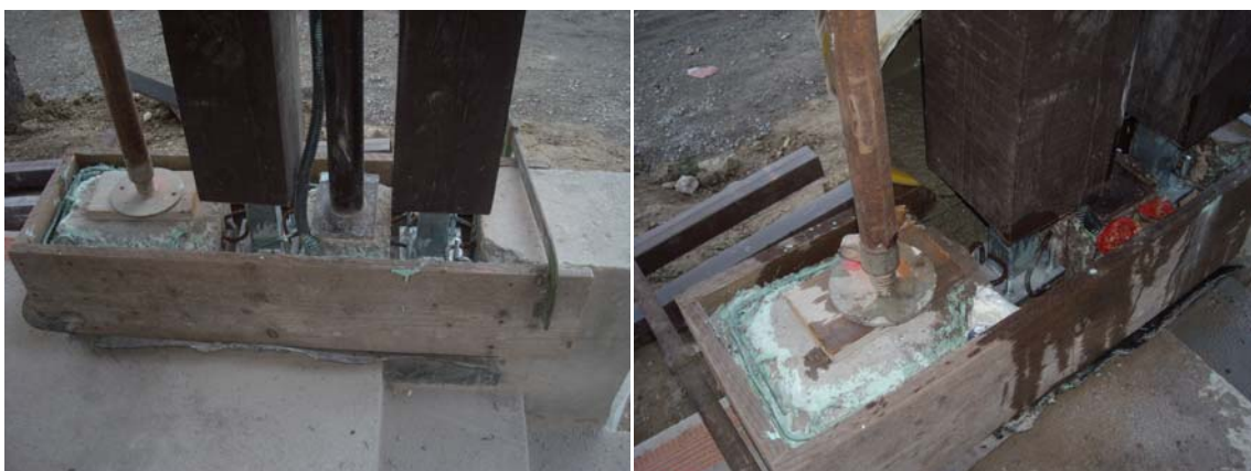
Fig.78 Fig79- Cassero per il getto di ripristino (fonte P.M.V.C.)
