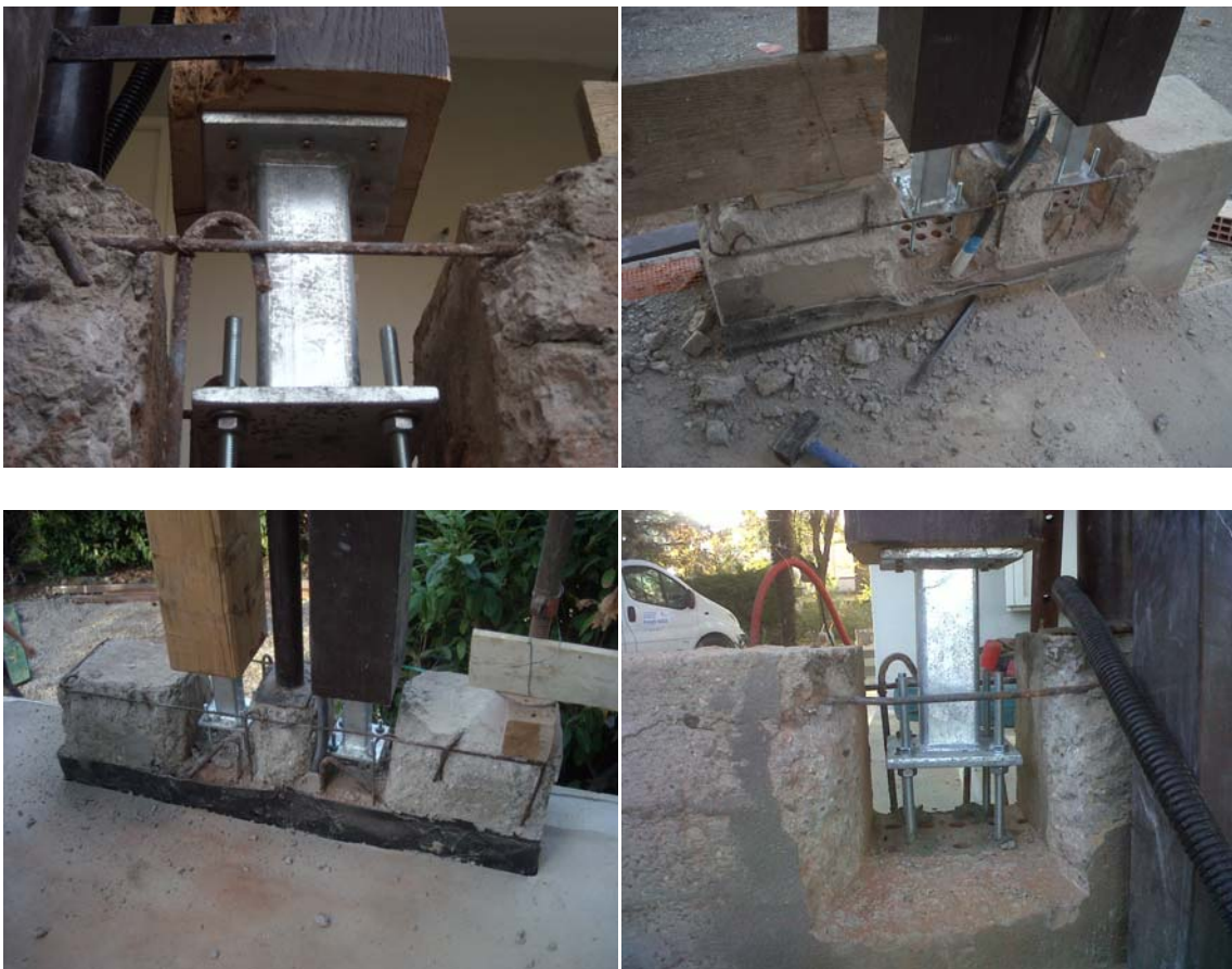
Fig.76- Ripristino della funzione portante dei pilastri (fonte P.M.V.C)
