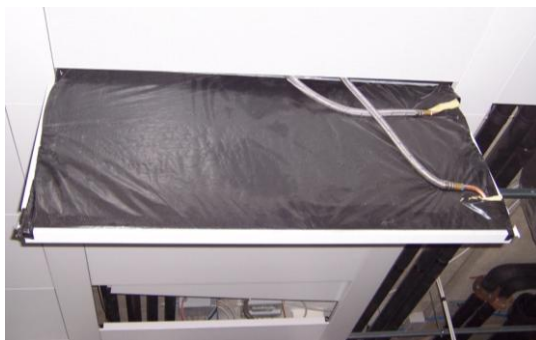
Figura 6.13- Foto, pannelli radianti, attacco
