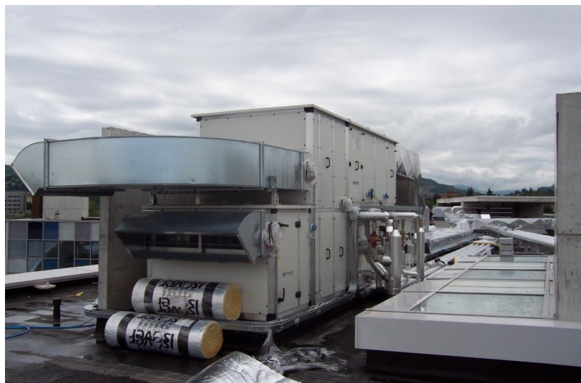
Figura 6.15- Foto, UTA in copertura
