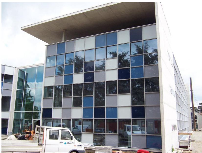
Figura 6.5 –Foto, prospetto Ovest del Corpo B
