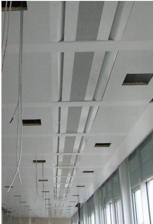
Figura 6.11 - Foto, travi induttive
