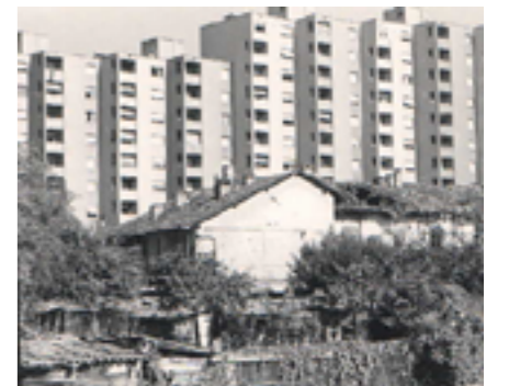
Fig. 34 Cascina Creta Vecchia in abbandono
