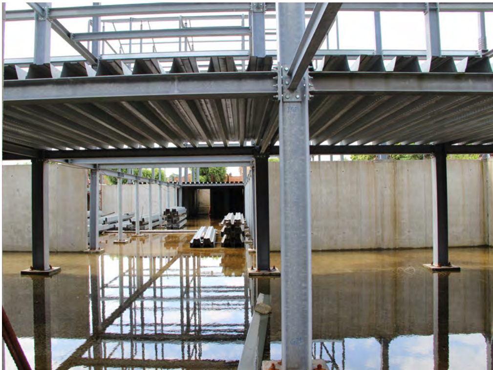
Stato di fatto del seminterrato
